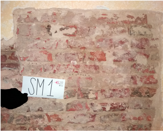
Fig. 13. Case study n.1. Window of masonry after plaster removal.
