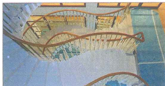
Corrimano personalizzato per Dolce & Gabbana, 60x40 mm, a partire da rovere grezzo Bendywood® di dimensioni 50x80x6.600 mm, piegati a mano e fissati su una piattina di acciaio.
