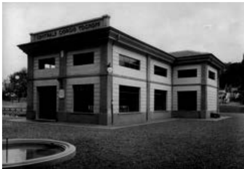
2. Sarzana (Sp), Centrale Generale Tognoni nel 1930 (foto Archivio Consorzio Canale Lunense) 2. Sarzana (Sp), Tognoni hydroelectric power station in 1930 (photo Archivio Consorzio Canale Lunense)
