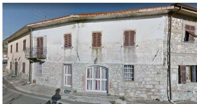
Figura 6. Esempio di edificio in classe M1.
