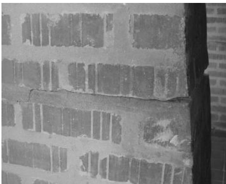
A sinistra: Scuola di Arti Plastiche, Dettaglio di una lesione nei contrafforti, 2006 (Michele Paradiso)
