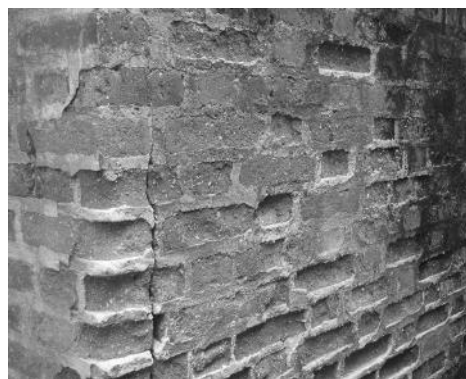
A sinistra: Scuola di Arti Plastiche, Dettaglio di una lesione nei contrafforti, 2006 (Michele Paradiso)
