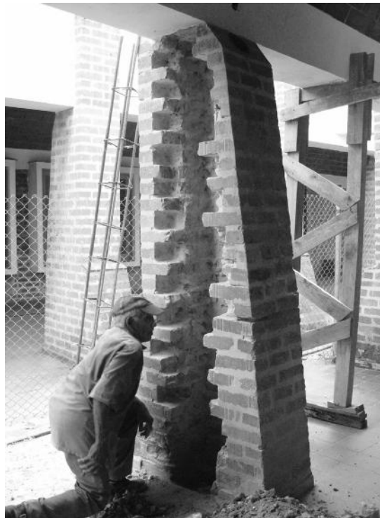
Esempio di consolidamento aggressivo del contrafforte, 2007 (Michele Paradiso)
