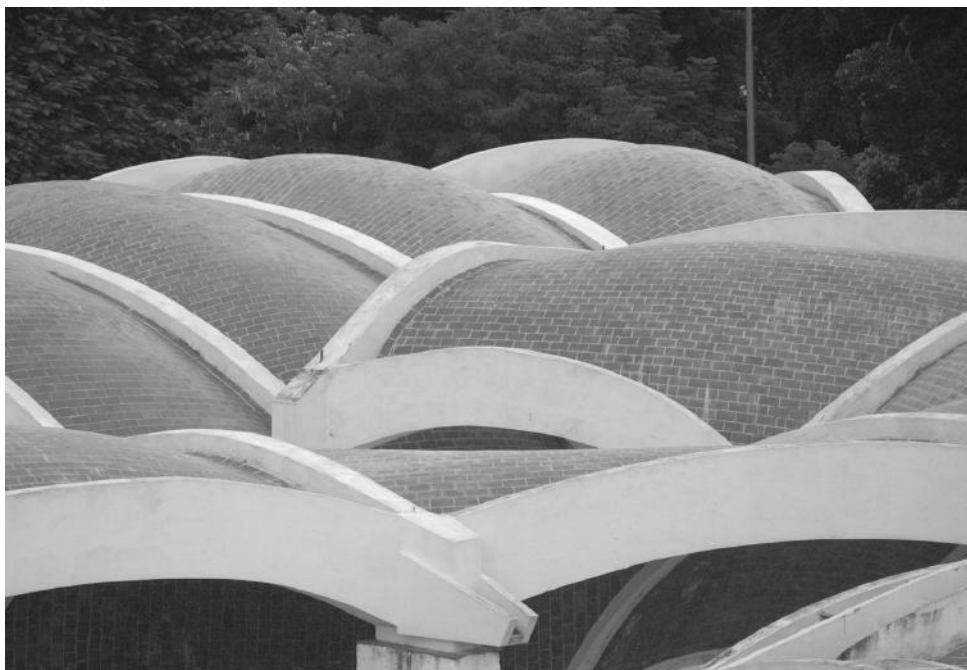
Tetti restaurati della Scuola di Danza Moderna, 2011 (Michele Paradiso)
