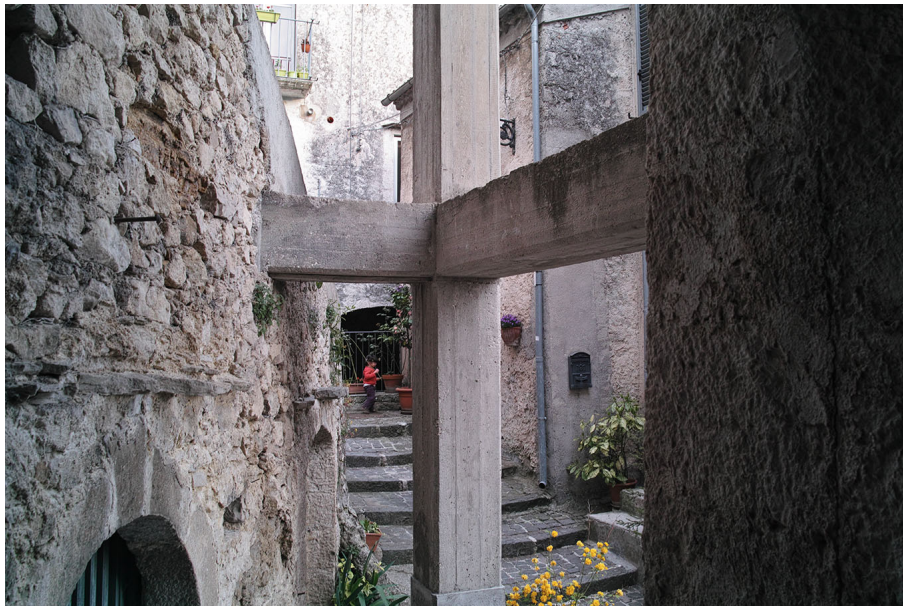
Figura 4 | Alcuni interventi di consolidamento delle strutture murarie, in questo caso anche sostegno per un piccolo parcheggio pubblico lunga la via S.Michele, l'unica carrabile che struttura l'intero centro nel suo sviluppo verticale (foto M.Carta).
