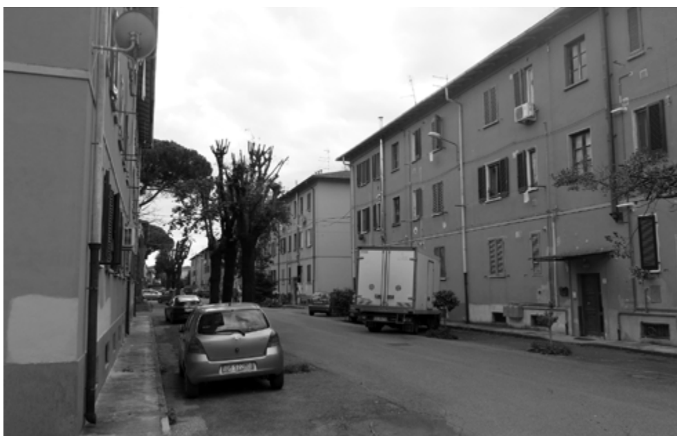
Fig. 2. Gli edifici da demolire.
