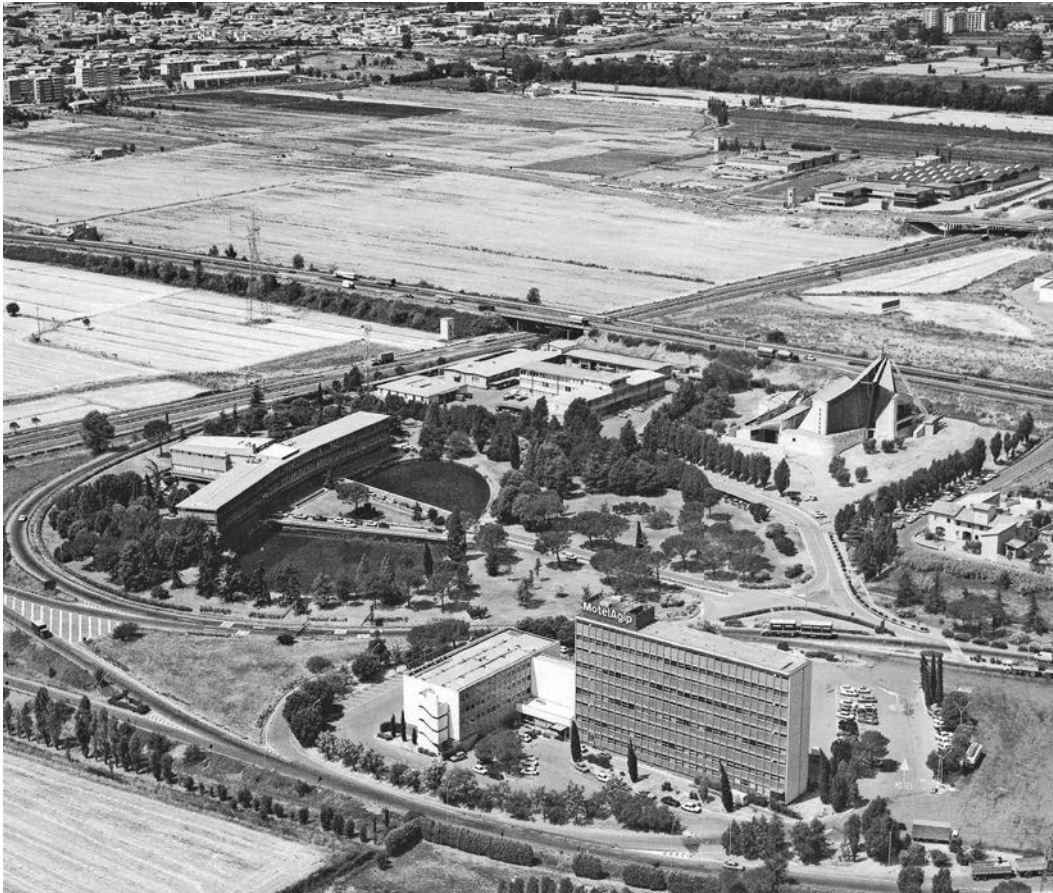
Chiesa di San Giovanni Battista in una fotografia del 1986. Nell'immagine è visibile l'incrocio dell'Autostrada A1 (Milano-Napoli) con la A11 (Firenze-Mare) in prossimità del quale vi sono il palazzo Fagnoni (Sede di Gestione della Autostrada del Sole), la chiesa di San Giovanni Battista e il motel AGIP
