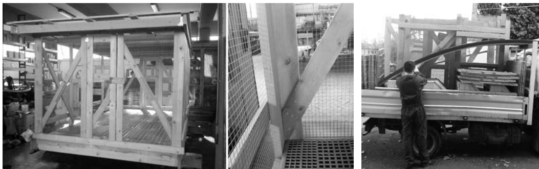
Figura 32. Assemblaggio in officina
