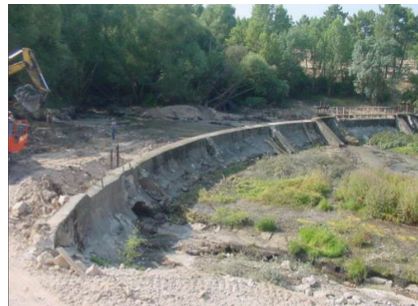
(a) Salto de Abajo dam: rehabilitation phase.
