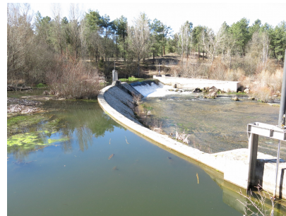
(b) Salto de Abajo: working dam.
