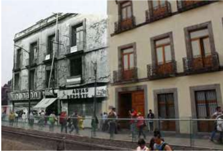
Fig.51 - Reconstitución digital de la antigua Casa de las Campanas, fotografía base de 1960. Para esta etapa ya existe un deterioro importante en la fachada, principalmente en aplastados. Técnica usada Photoshop.
