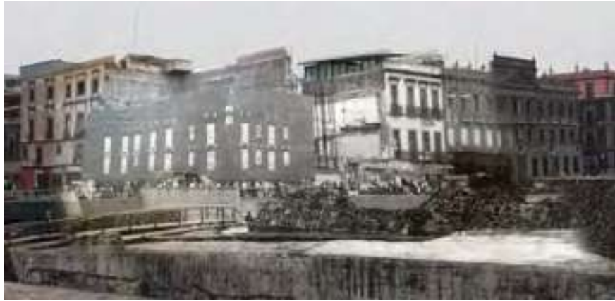
Fig.55 - Reconstitución digital de la acera oriente de la Av. República de Argentina, fotografía base de 1999. Se muestra a casa de las ajaracas en riesgo de colapso cubierta por una gran lona. De igual forma se observa a la Casa de las Campanas prácticamente demolida en su totalidad. Técnica usada Photoshop.
