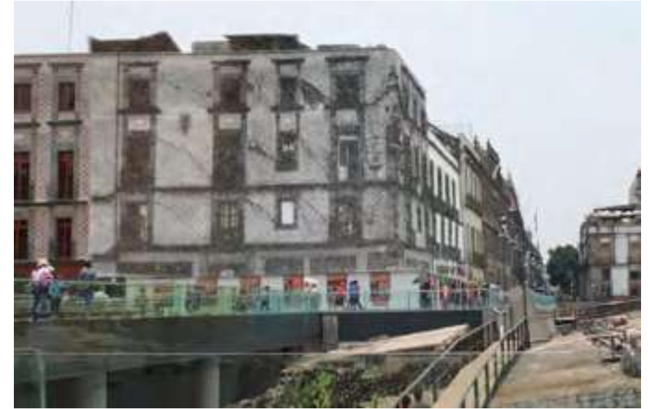
Fig.53 - Reconstitución digital de la fachada norte de la Casa de las Ajaracas, fotografía base de 1991, donde es evidente el daño existente en el inmueble, delatado por la cantidad de grietas en fachada y hundimientos diferenciales. Técnica usada Photoshop.
