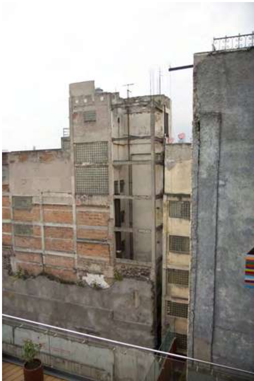
Fig.129 Vista di un fabbricato all'interno dell'isolato, che permette di comprendere la sovrapposizione e l'accostamento di strutture in cemento armato con edifici antichi
