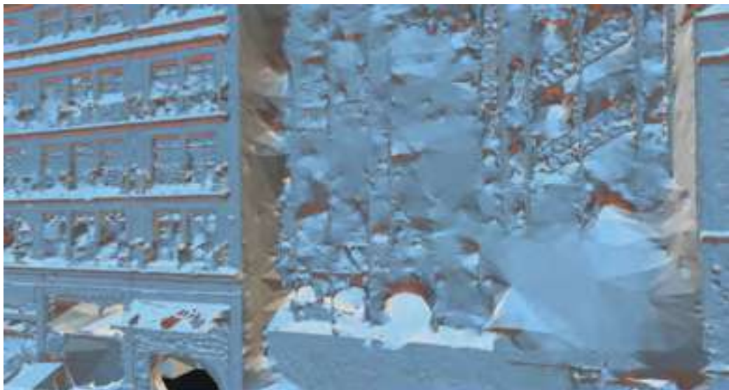
Fig.109 Immagine del modello mesh di un edificio moderno dell'isolato con facciata a cortina di ferro e vetro: i sistemi di acquisizione fotogrammetrici non consentono di ricostruire correttamente tali superfici a causa dei numerosi riflessi
