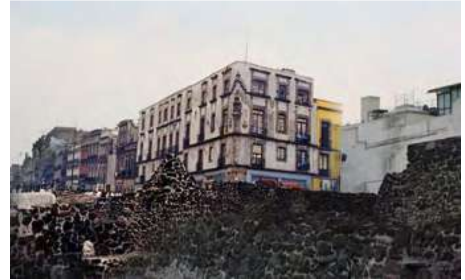
Fig. 49 - Reconstitución digital de la casa de las Ajaracas vista desde el interior del Templo Mayor, fotografía base de 1980. Se observa el hundimiento diferencial del conjunto, en consecuencia, el apareamiento de grietas que terminaron por deteriorar al inmueble. Técnica usada Photoshop.
