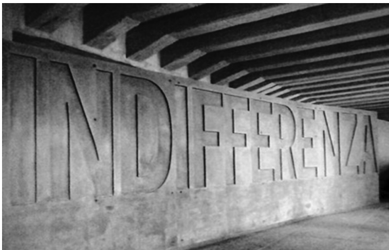
Figura 1.17. Binario 21. Sotterraneo della stazione di Milano.
