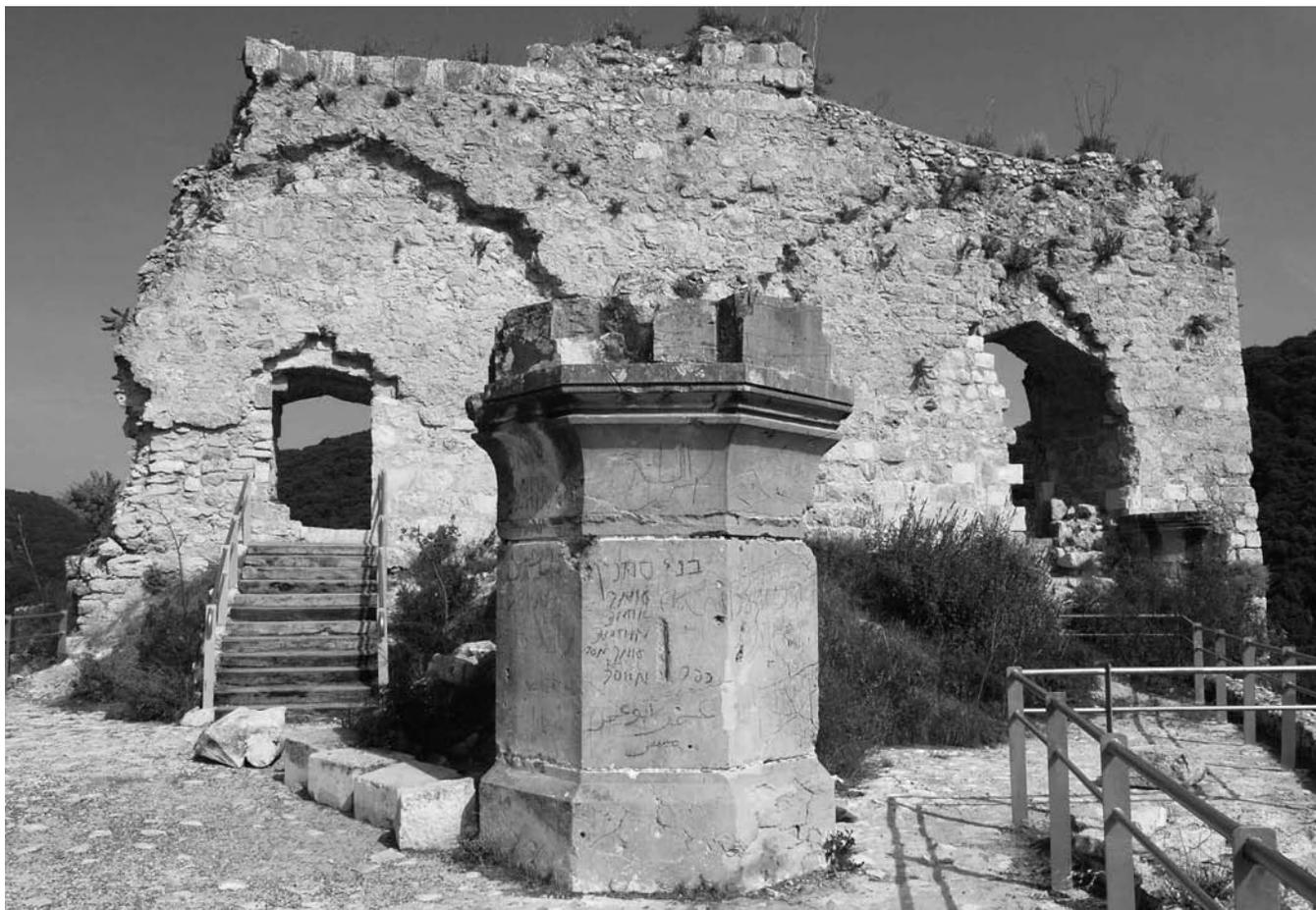
16. Vista interna della sala poligonale dal pilastro ottagonale, III area del castello d'apice. Si notino le tracce dei costoloni che dovevano caratterizzare le ampie volte della sala, secondo uno schema quadrangolare a due navate per due campate. Sull'estrema destra, il cantonale finito del muro che ha giacitura cardinale nord-sud.
