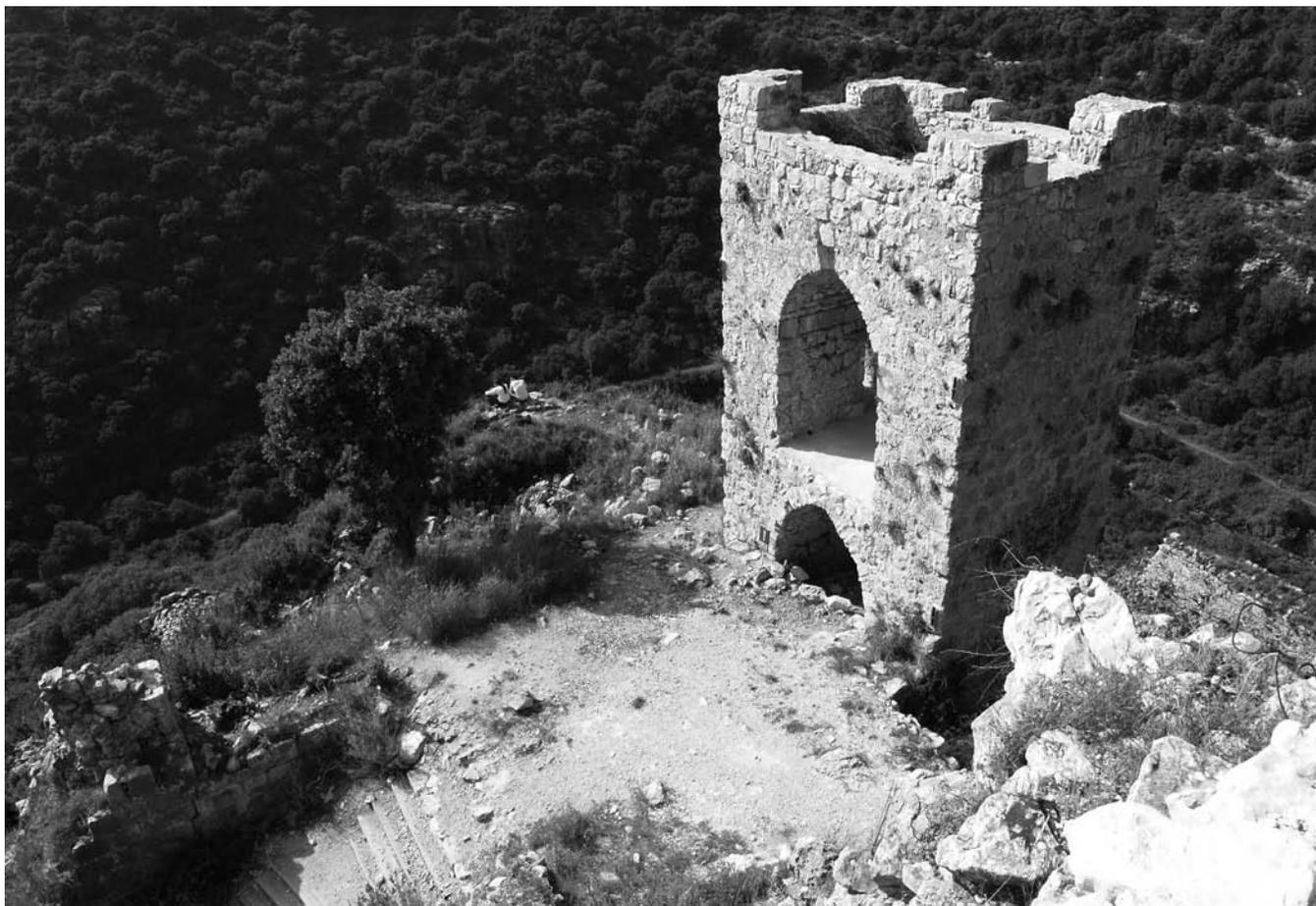
17. La Gate Tower, veduta d'insieme dell'area circostante che poggia su strutture impostate diversi metri più in basso. Da notare come la torre sembra addossarsi ad una struttura preesistente di cui si scorge un cantonale. Le scale sono state ricavate a stretta fra due brani di muri dalle funzioni ancora da indagare.
