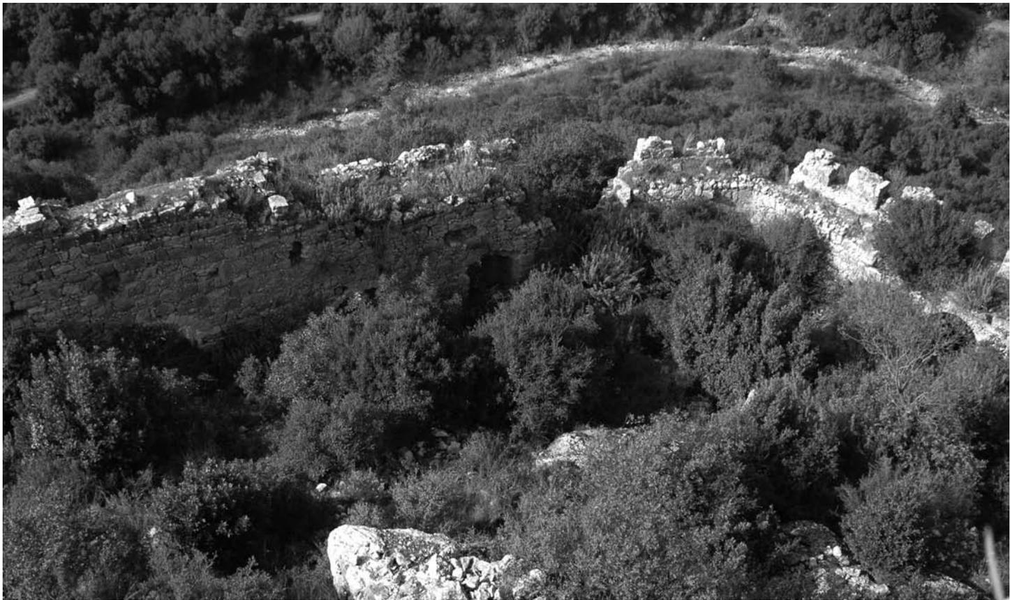
18. Vista dall'alto della quinta area, posta contro crinale verso nord ovest. Si leggono bene le merlature il piano del percorso di ronda e le aperture che caratterizzano il circuito murario. Si segnala ulteriormente la modalità di realizzazione dell'apparecchiatura muraria effettuata con conci sbazzati grossolanamente e zeppati. Concordando con il Rey (Rey, G. 1871, p. 148) questo è un tipico manufatto teutonico.
