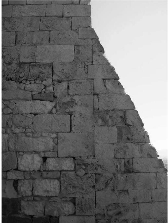
39. *Castello San Michele a Cagliari. Particolare della scarpa in appoggio alla struttura. Esempio di un riadattamento statico finalizzato alla soprelevazione della struttura e con valenza balistica.*
