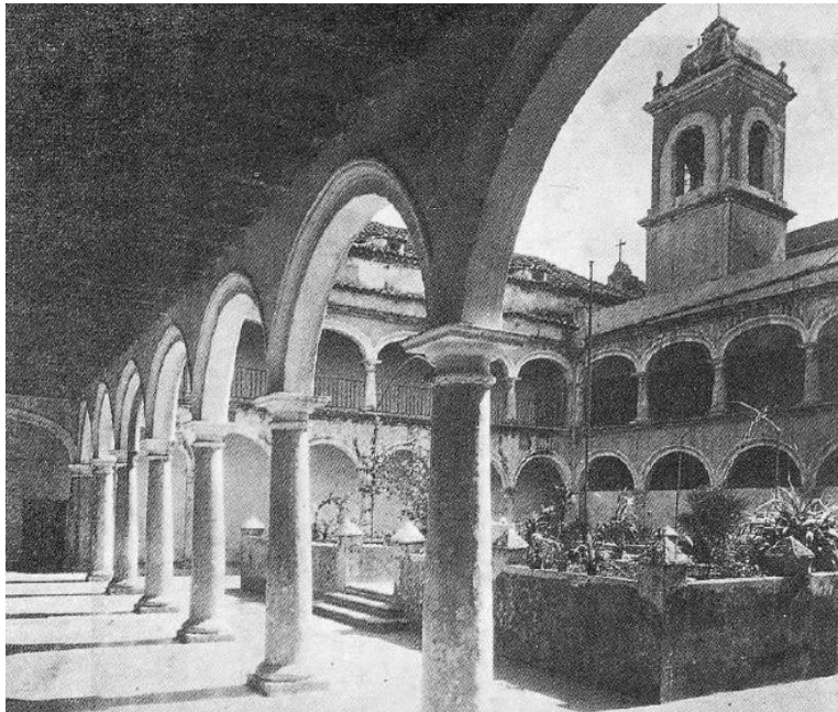
Immagine B: Foto storica del primo chiostro del Convento, appartenente alla prima fase costruttiva è circondato su tutti i suoi lati da un portico con archi a tutto sesto al piano terra e policentrici al
