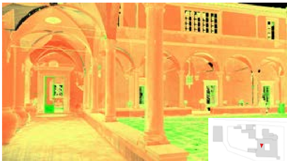
Figura 68. Due vedute del chiostro: full resolution della point cloud acquisita da rilievo laser scanner.
