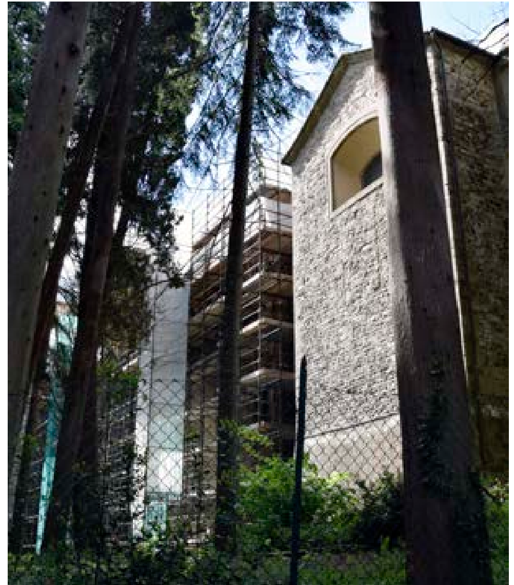
Figura 60. Badia a Passignano: gli esterni della chiesa visti dal giardino di Nord-Est.
