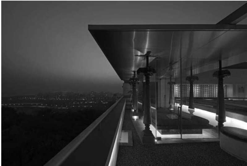
7. Il padiglione di vetro e metallo sorretto dalle colonne centenarie in granito e legno [Fonte: Sebastian Zacharia, Photographix].
