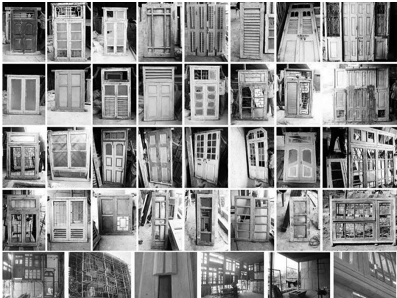
5. Abaco degli infissi recuperati e fasi di ri assemblaggio [Fonte: Sebastian Zacharia, Photographix].
