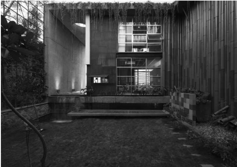
6. La corte interna: in evidenza il muro di tubi, la fioriera con mattonelle Kitsch e, sullo sfondo, il rivestimento in piatti metallici arrugginiti [Fonte: Sebastian Zacharia, Photographix].
