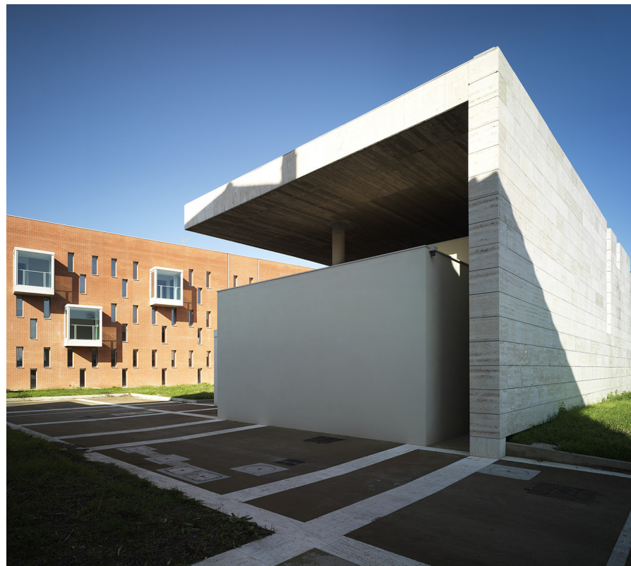
Rivestimenti delle facciate dei due blocchi.
