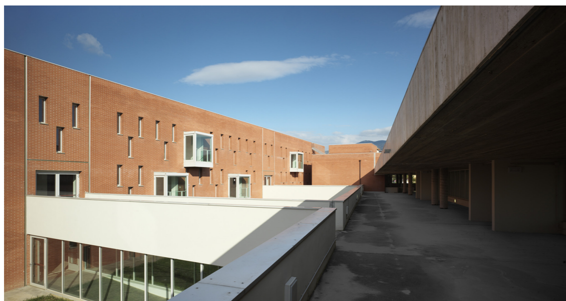
I due edifici convergenti dell'ampliamento. In fondo il corpo della biblioteca.
