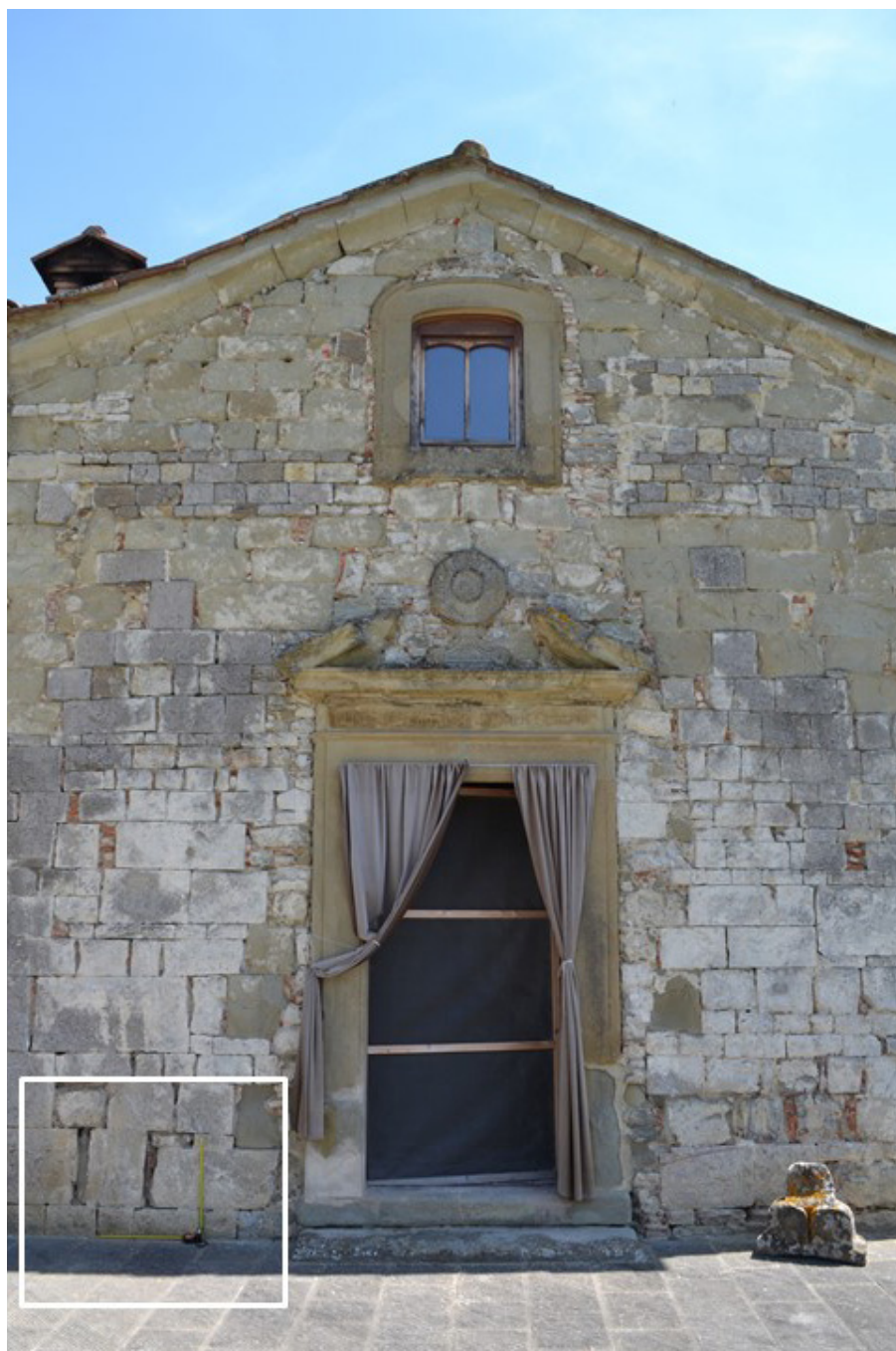
Fig. 4. Facciata della chiesa di Sant'Agata a Orgi (Castel S. Niccolò - AR). Particolare delle murature di XII/XII secolo
