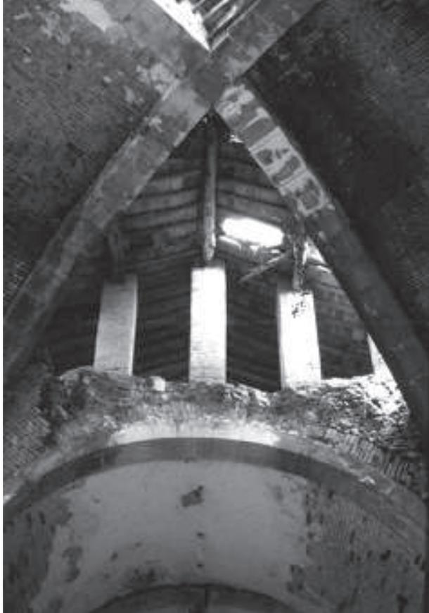
Il deterioramento della muratura è dovuto in parte allo sviluppo di vegetazione che facilmente cresce all'interno dei commensuri murari e in parte al formarsi di fessure che hanno contribuito ad alterare il meccanismo strutturale originario.
