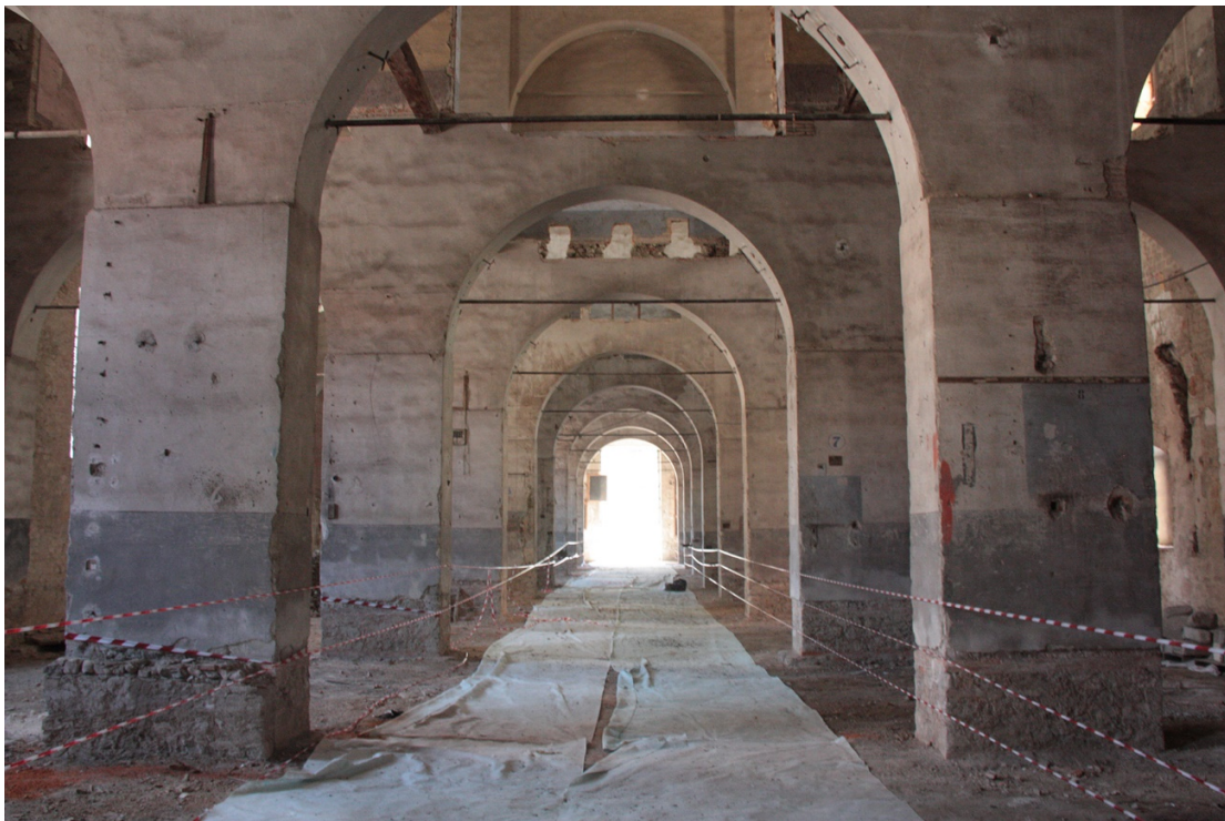
Figura 8. Setti trasversali con aperture ad arco.
