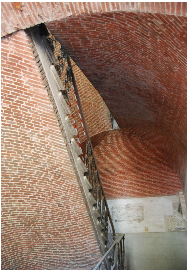
Figura 7. Scala in muratura con imposta a semi-volta a padiglione. Fonte: Archivio degli autori, 2017
