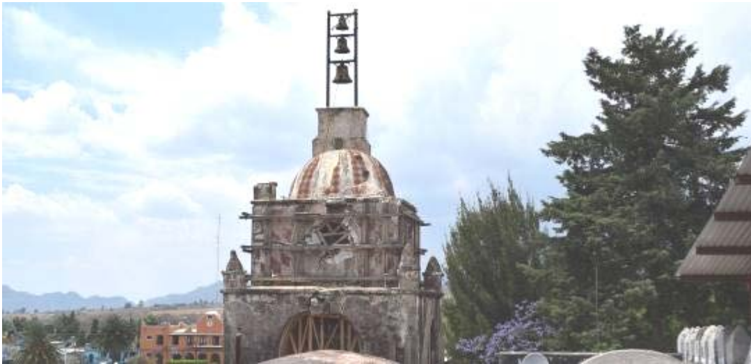
Immagine 74 - Secondo e terzo corpo della Torre dell'Orologio
