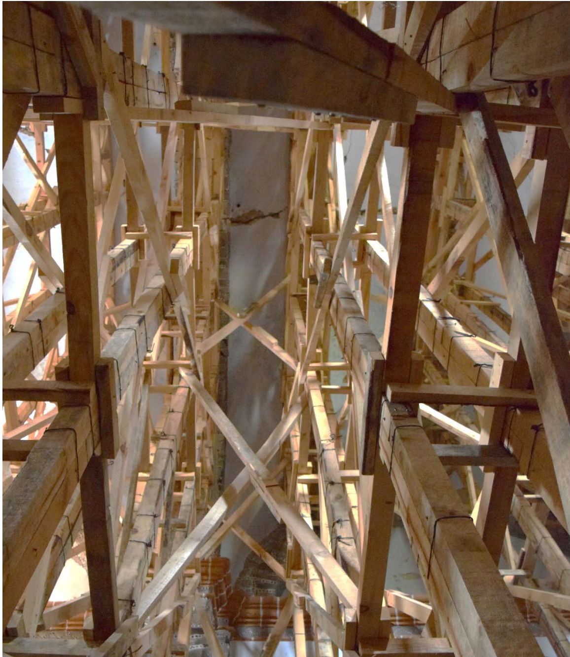
Immagine 83 - Strutture provvisionali nella chiesa
