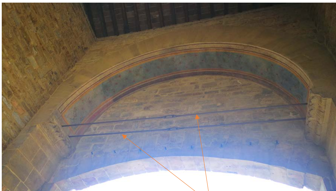
Immagine 50 - Messa in opera delle due catene
