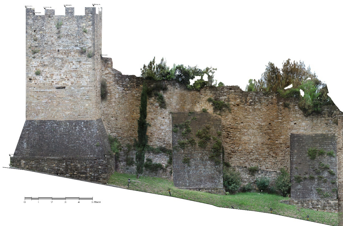
Immagine 26 - Porzione di Fotopiano del prospetto di mura su via Belvedere
