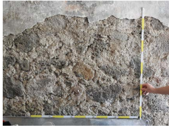
Immagine 101 - Dimensioni dei conci dei maschi murari della chiesa e del chiostro centrale
