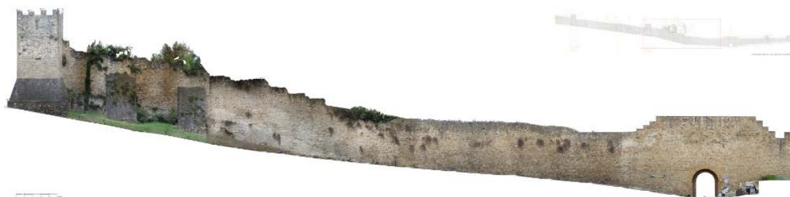
Immagine 25 – Fotopiano del prospetto di mura su Via Belvedere
