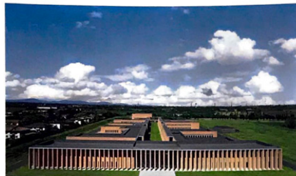
Aus der Vogelschau ist die Struktur der Europäischen Schule Parma gut zu erkennen. Die U-förmigen Einheiten grenzen an einen lang gestreckten Hof und öffnen sich zur Landschaft.
