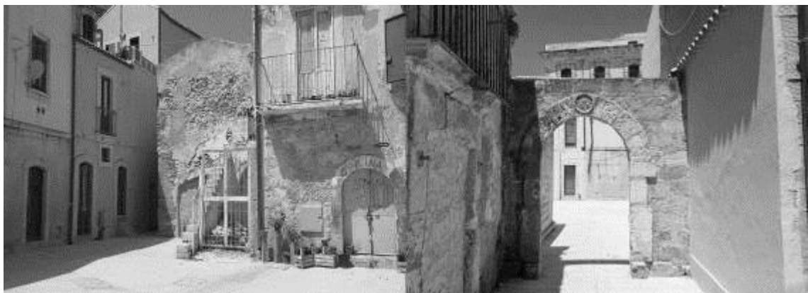
Figura 3. C1, corte con accesso da via Dione.
