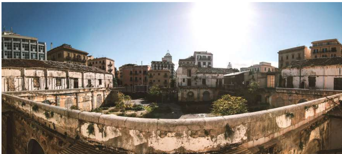
Figura 5. Panoramica cortile interno.
