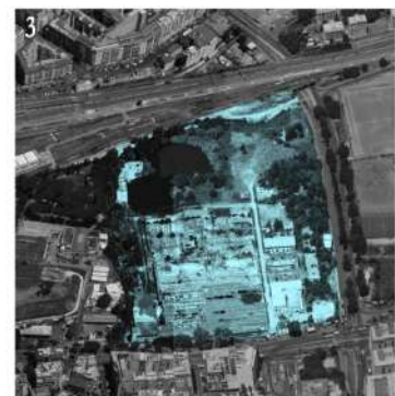
3 Ex Industria Snia Viscosa Municipio V - Via Prenestina 173 Sistema di padiglioni con copertura a shed
