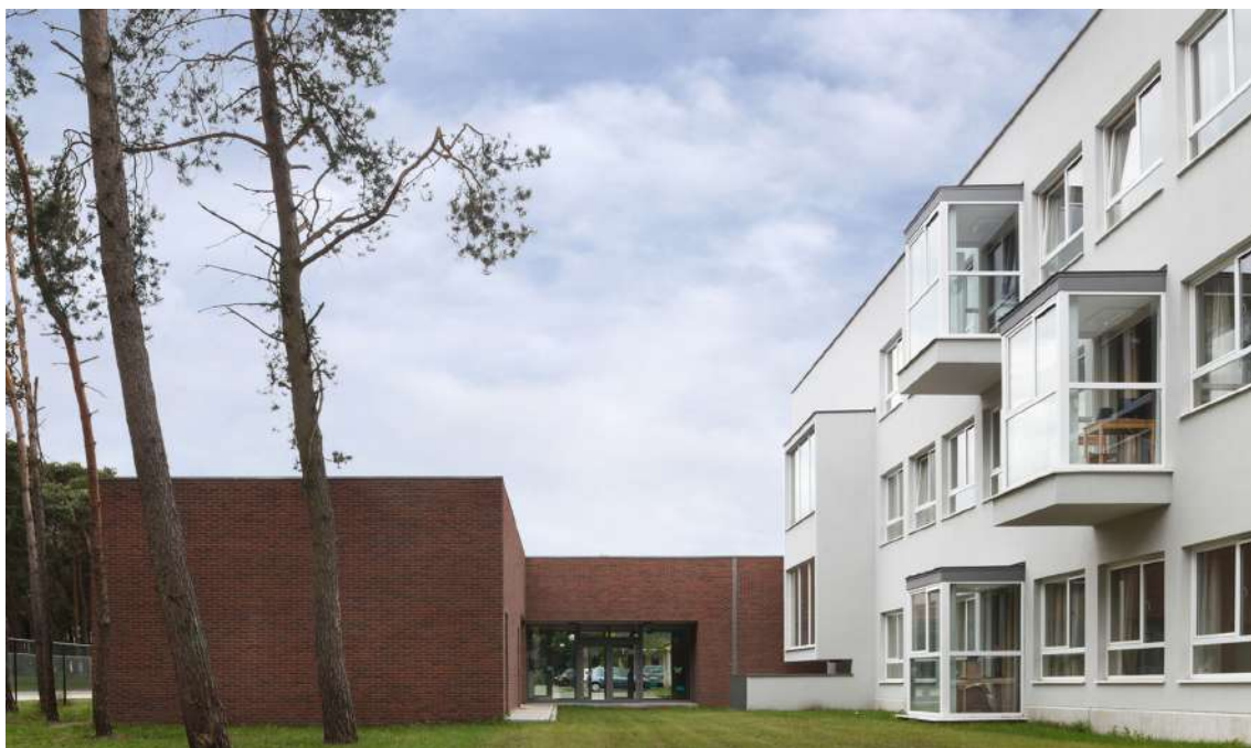
Figura1. Vista di uno dei fronti delle camere e della testata del corpo basso di servi in cui sono collocati i monolocali [Foto di Stijn Bollaert].
