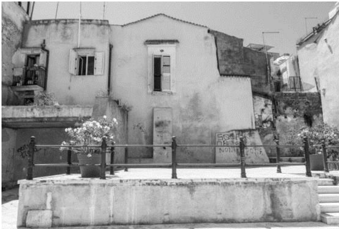
Figura 4. C2, corte con accesso da via Dione.
