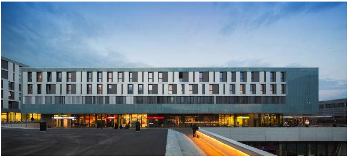
Figura 2. Vista dei prospetti esterni del nuovo edificio destinato ad ospitare i servizi e le residenze universitarie del Quartiere Nord [Foto: ©Fernando Guerra].
