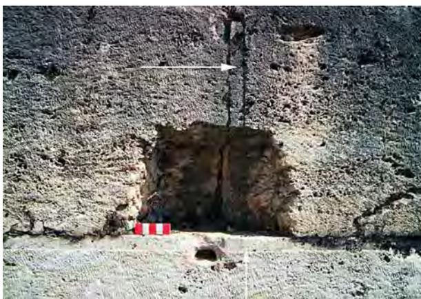
Fig. 59 Dettaglio della lavorazione con scanalature a fondo piatto lungo i margini dei blocchi in travertino del podio.
