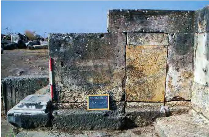
Fig. 8 Tamponamento di una lacuna nel tessuto lapideo dell'anta occidentale.
