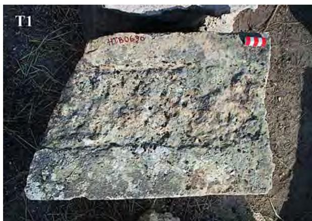
Fig. 56 Blocco in travertino T1 con *anathyrosis* sul piano di posa.
