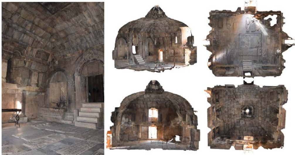
Figura 4 – interno del Gavitt nel monastero di Noravank, Armenia
