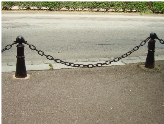
Figura 3. Andamento a catenaria di una catena sospesa.
