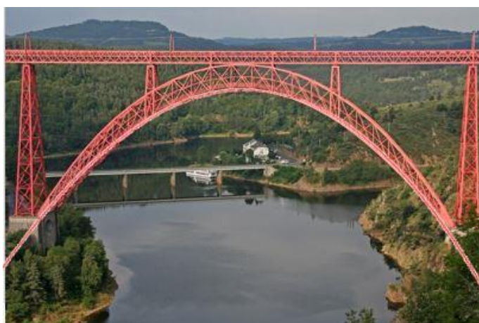
Figura 20. Parabole del ponte di Gerebit. Francia. Eiffel. 1880
