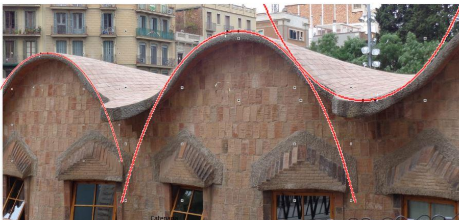
Figura 11. Le catenarie nel tetto della Scuola della Sagrada Familia. Gaudí
