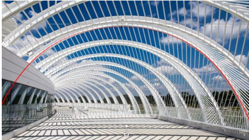
Figura 27. Catenarie pesate della Florida Polytechnic University. Calatrava
