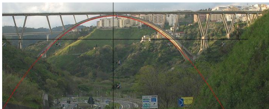
Figura 22. Arcata parabolica del Viadotto Bisantis. Catanzaro. Ing. Morandi
