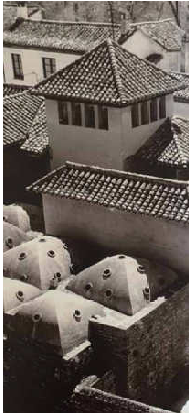
Fig.81 Fotografia storica delle coperture e dalle torri dei Bagni della moschea.
