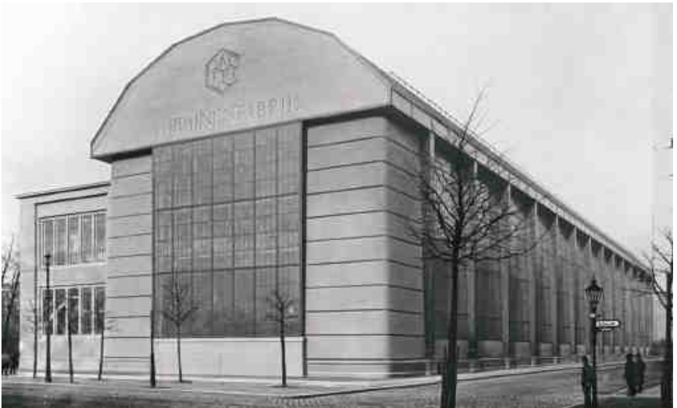
Fig. 12 Peter Behrens - AEG Turbinenfabrik, Berlino, 1909.
