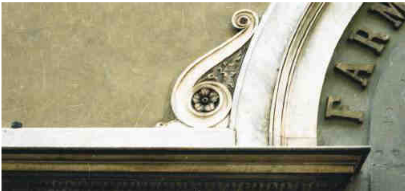
Fig. 36 Dettaglio della mostra in marmo della Farmacia di San Marco in via Cavour, ancora in attività all'epoca del censimento 1985-90.
