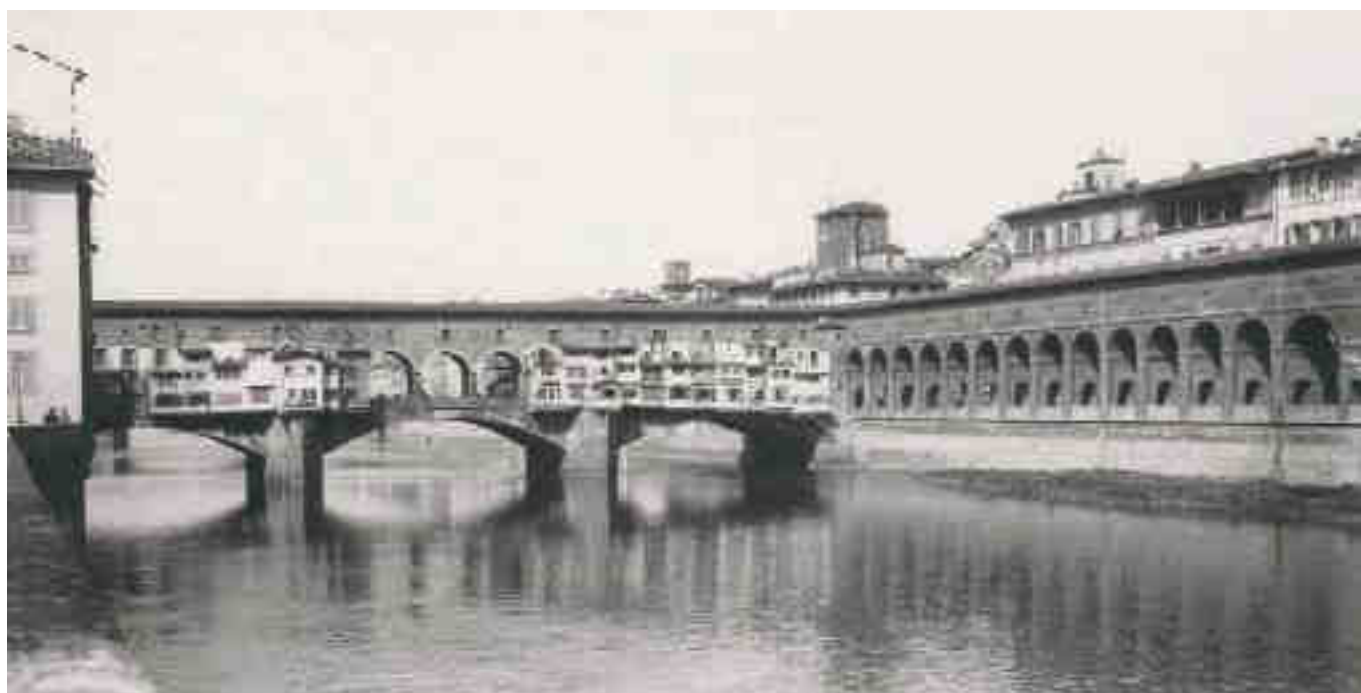
Figg. 19-20 Lungarno degli Arcibusieri e Ponte Vecchio (sopra : 1860 ca.; sotto: 1885 ca.), Raccolte Museali Fratelli Alinari (RMFA) - Collezione Aranguren, Firenze. Il loggiato sottostante il Corridoio Vasariano poco dopo la sua realizzazione fu tamponato per ospitare botteghe, che furono alluvionate il 6 novembre 1864 e quindi eliminate negli anni 1884-85.
