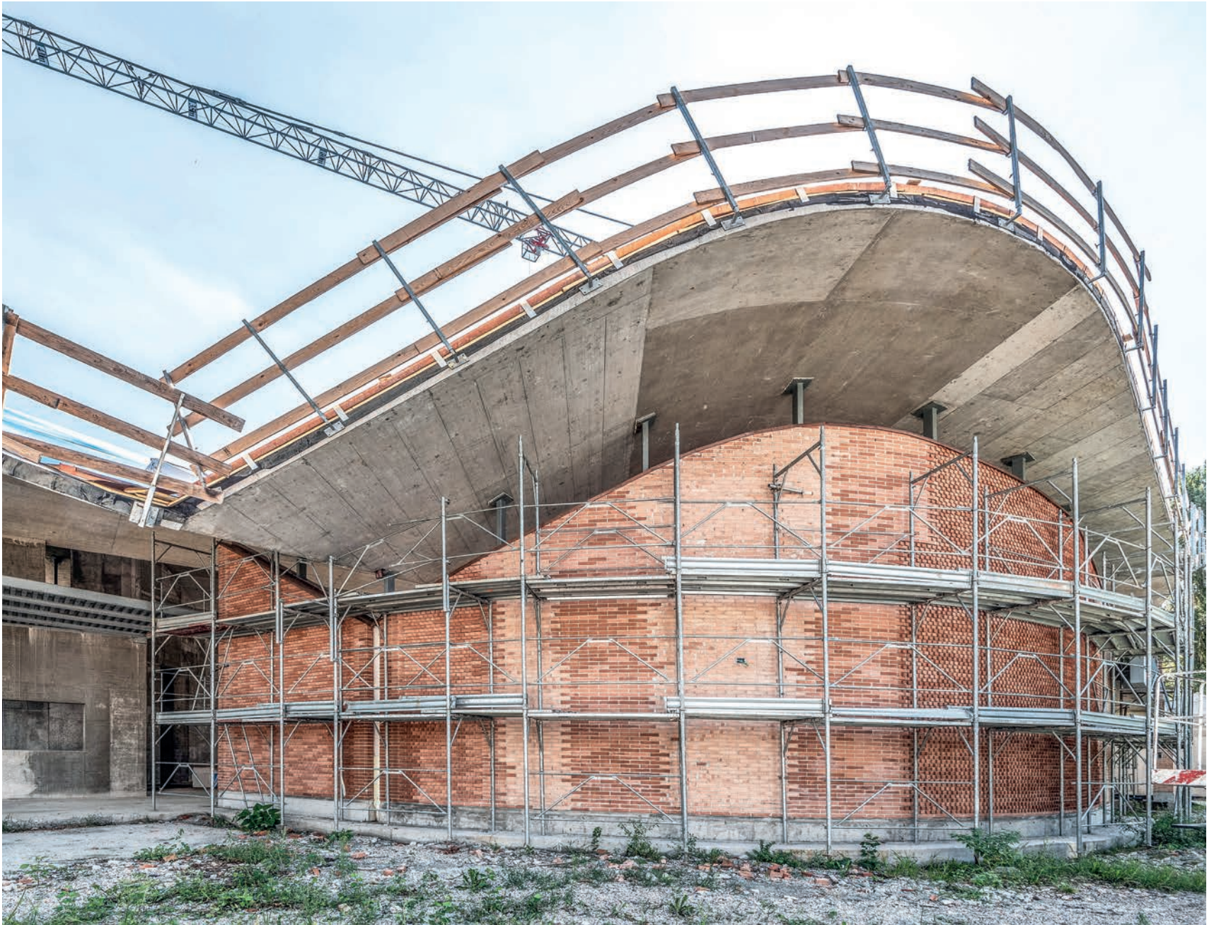
Immagine di cantiere: messa in opera del rivestimento esterno in laterizio. © P. Fassoli
