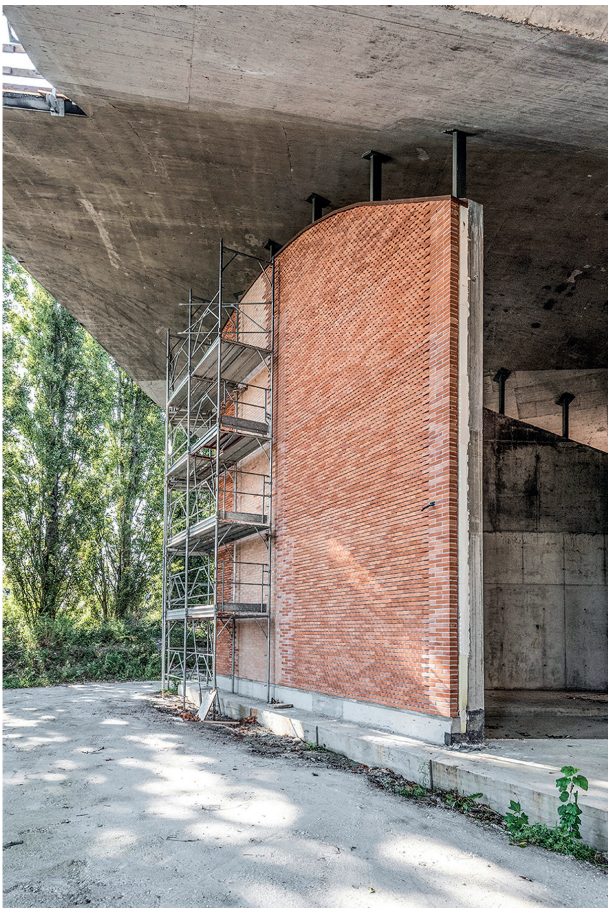
Dettaglio di messa in opera del rivestimento in mattoni. © P. Fassoli
