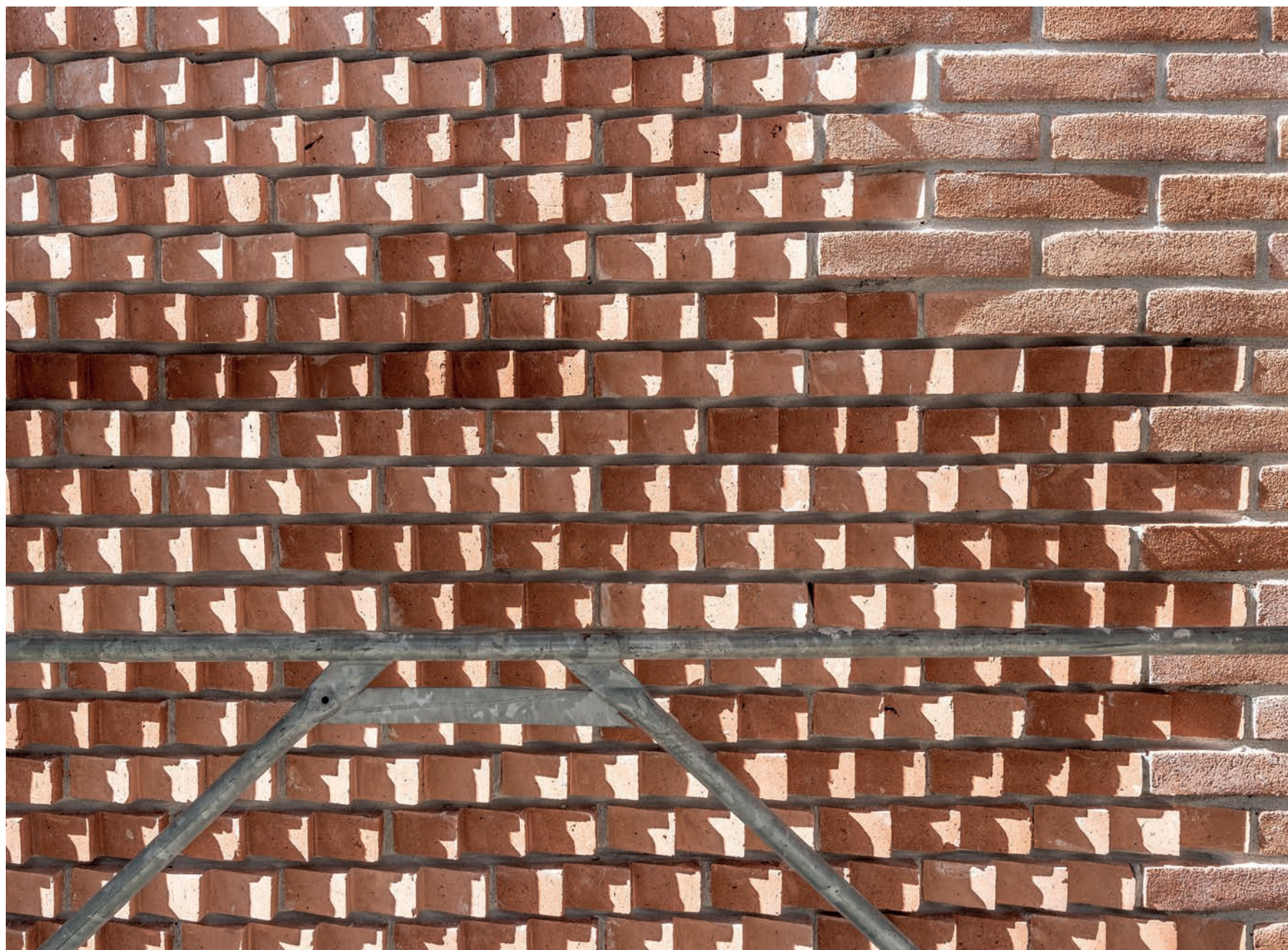
Rivestimento in mattoni faccia a vista con profilo esterno seghettato. © P. Fassoli
