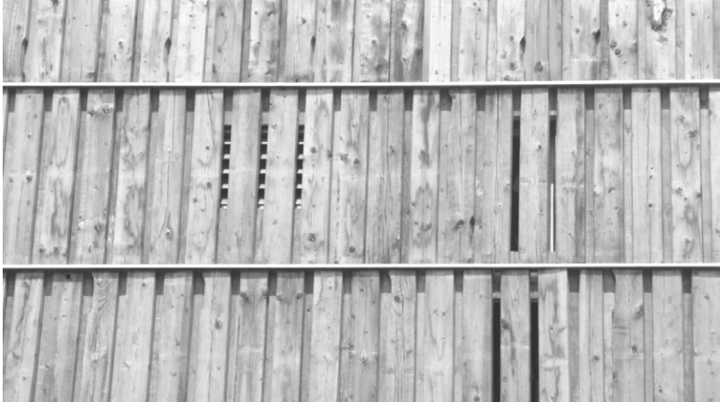
Figura 4. Dettaglio della facciata di Villa Welpeloo, realizzata utilizzando doghe di legno provenienti dal disassemblaggio di bobine per lo stoccaggio dei cavi elettrici [Foto: Superuse Studio].
