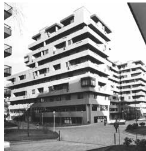
Edificio Via Trivulzio a Milano
