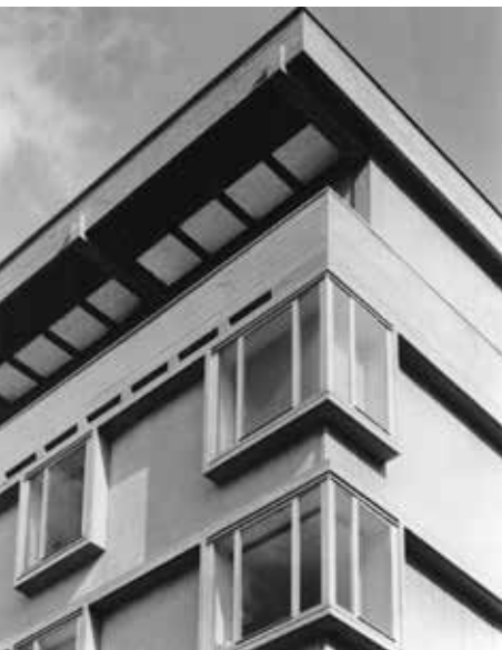
Edificio per uffici de La Fondiaria in viale Spartaco Lavagnini a Firenze
