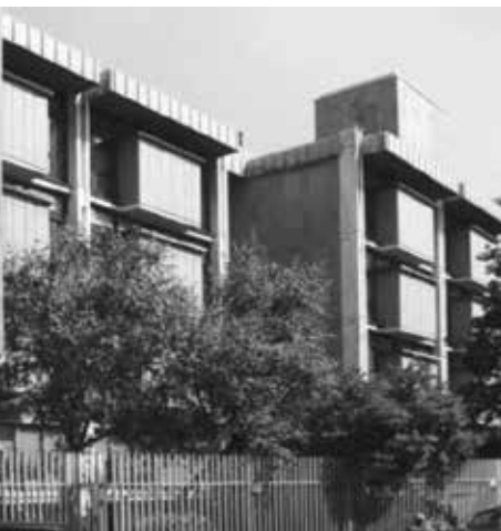
Edificio Via Parini-Via Appiani a Milano
