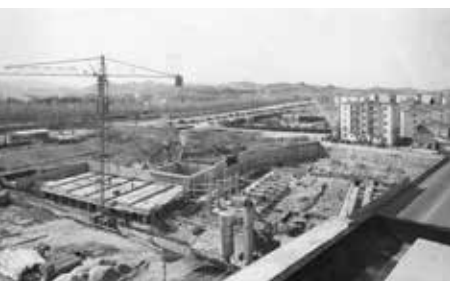
Veduta del cantiere
