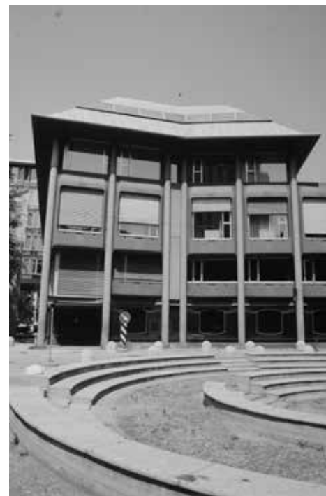
Edificio Via San Giovanni sul Muro a Milano
