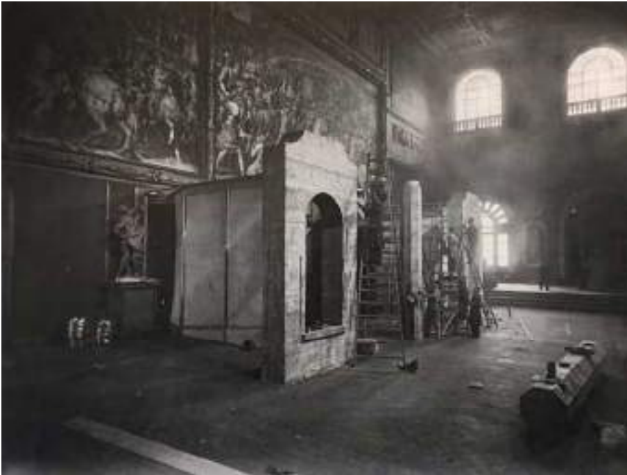
Fig. 2. Room 1: the Salone dei Cinquecento with the installation underway of the ten teatrini , detail of a teatrino under construction, Florence, Gabinetto Fotografico delle Gallerie degli Uffizi. Courtesy Ministero per i Beni e le Attività Culturali.
