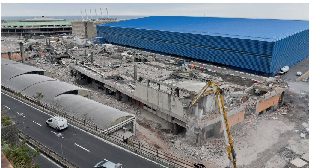
Figura 6 | Demolizione dei Padiglioni della Fiera del Mare, 2021. Fonte: https://concretenews.it/2021/04/29/demolito-il-padiglione-c-della-fiera-di-genova/
