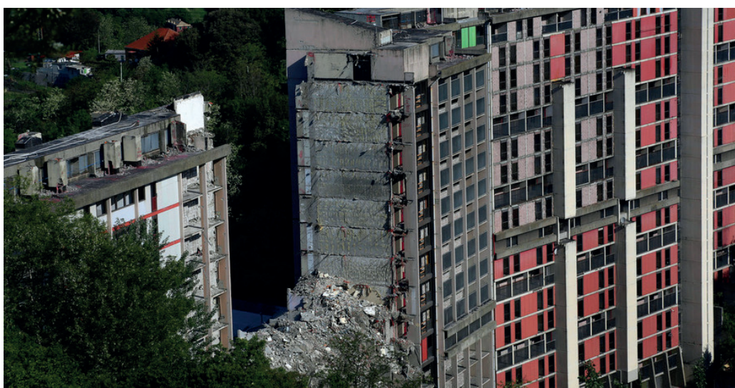
Figura 2 | Demolizione della Diga di Begato in corso, 2021, da: https://www.lavocedigenova.it/2021/05/11/leggi-notizia/argomenti/attualita-4/articolo/diga-di-begato-proseguono-i-lavori-demoliti-15000-metri-cubi-di-cemento-armato-foto.html
