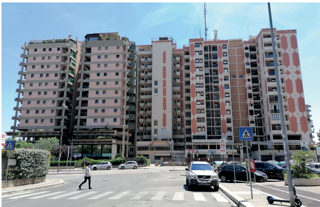
Figura 4 | Bari, lottizzazione di aree per terziario-direzionale. Foto dell'autrice.
