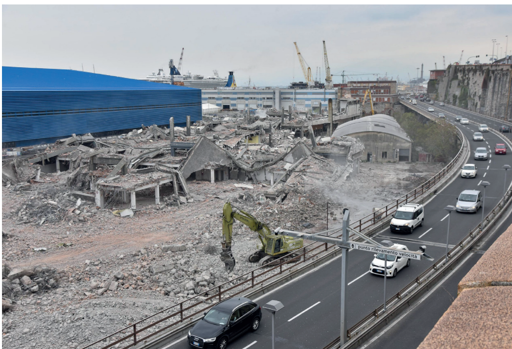
Figura 5 | Demolizione dei Padiglioni della Fiera del Mare di Genova, 2021, da: https://liguria.bizjournal.it/2021/04/waterfront-di-levante-conclusa-in-cinque-giorni-la-demolizione-del-padiglione-c-della-fiera/
