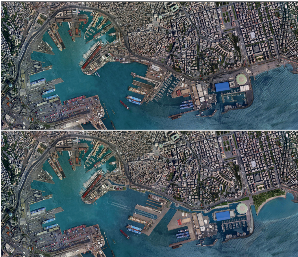
Figura 1 | Waterfront di Levante , prima e dopo. Fonte: Renzo Piano Building Workshop (RPBW), Fondazione Renzo Piano per la Regione Liguria, Comune di Genova e Autorità di Sistema Portuale del Mar Ligure Occidentale, 2017
