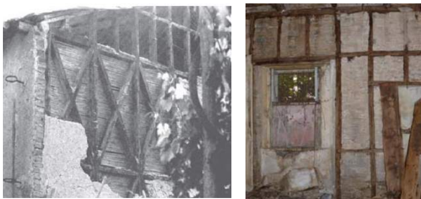
Figura 4.9 A sinistra: sistema baraccato nella provincia di Reggio Calabria (da Margagni, 2009); a destra: esempio di sistema Borbonico (da Ruggieri).
