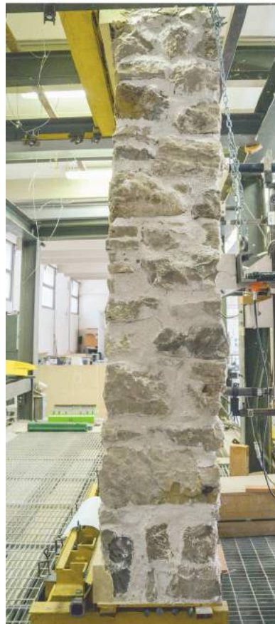
Figura 6.68 Quadro fessurativo lato B del pannello murario.
