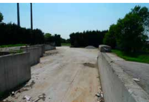
Operazioni di depaving sulla pavimentazione / Depaving operations (© MADE associati)
