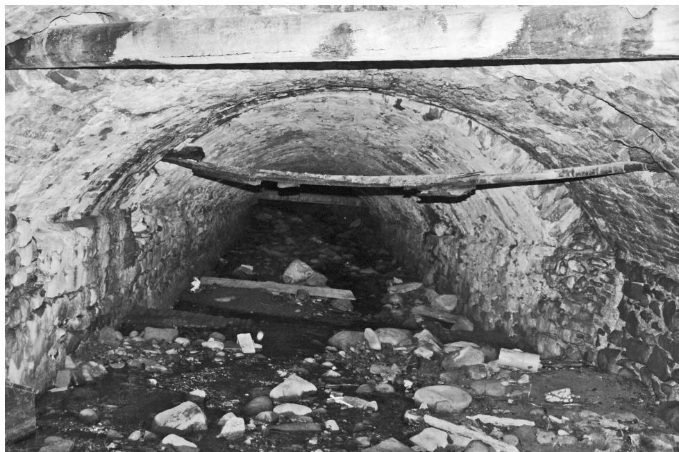
Fig. 7 – Ponte al di sotto del manto stradale di piazza Santo Stefano.
