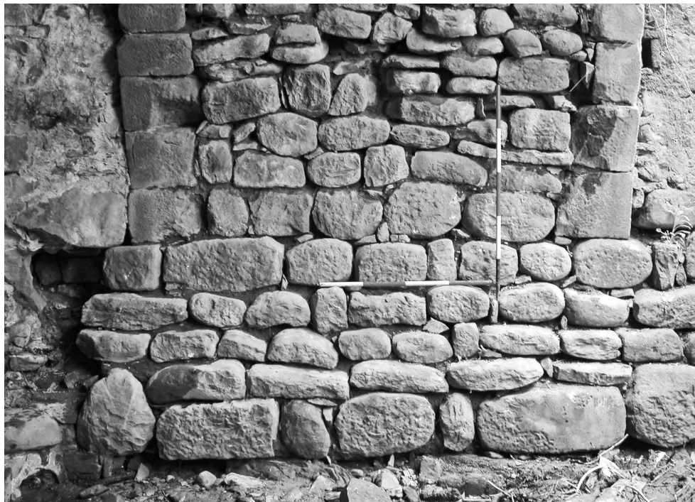
Figg. 1, 2 – Struttura del ponte posto attualmente alle spalle della torre campanaria della chiesa dei Santi Stefano e Niccolao e che consentiva l’accesso al primitivo borgo di Bareglia.
