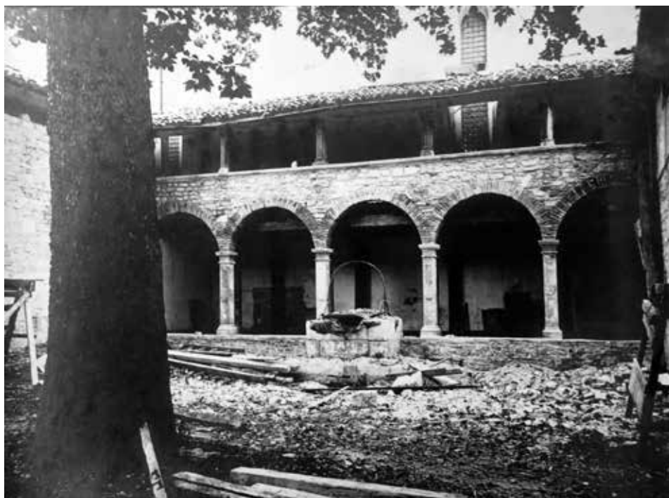
Chiesa di San Francesco, chiostro, post 1928, chiostro restaurato (in ACS, AA.BB.AA., Div. II, b. 260)
