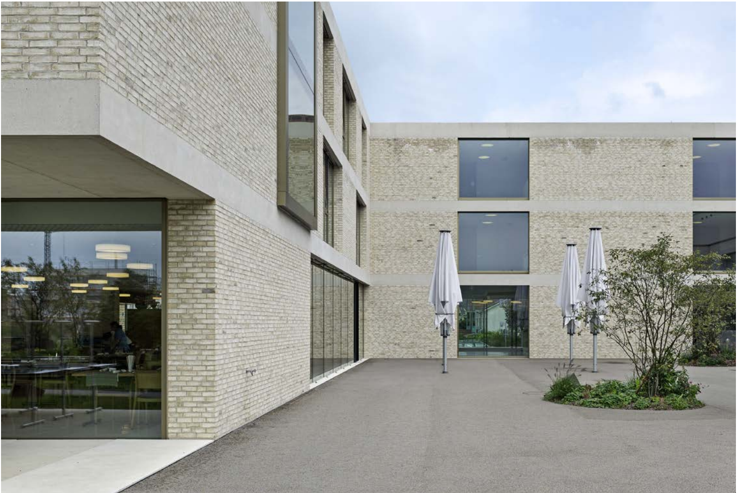
Vista della corte interna.
