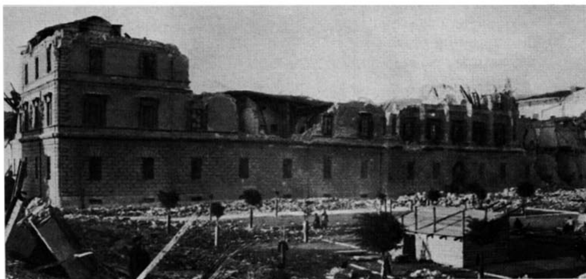
Fig. 4 – Parte sinistra del prospetto principale del Collegio militare dopo il terremoto (foto d'epoca).
