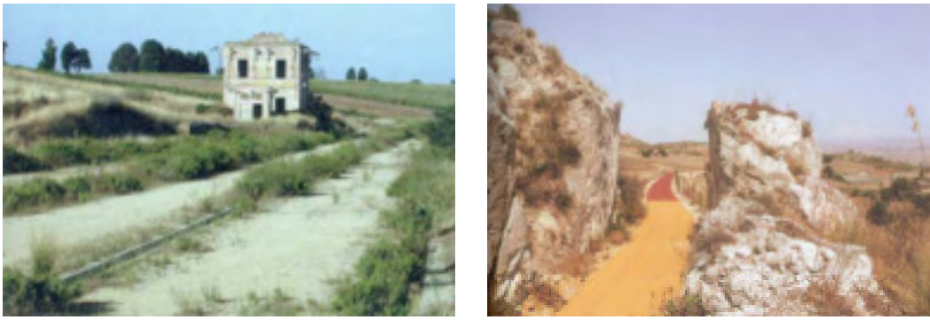
Figure 54 e 55. Il recupero delle linee ferroviarie dismesse in greenway si può fondare sull'organizzazione di pochi elementi per la sicurezza e la funzionalità del percorso, anche mediante il recupero di edifici e manufatti di servizio: in fotografia, stazione abbandonata lungo la linea dismessa tra Civitavecchia-Capranica. La creazione di una greenway può rappresentare così l'occasione per introdurre un rinnovato elemento di connessione di luoghi e paesaggi: greenway siciliana, sulle tracce della vecchia strada ferrata tra Caltagirone e Piazza Armerina.
