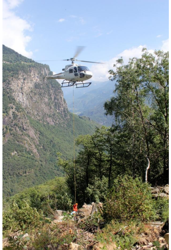
Figura A.36 - Installazione di colonna inclinometrica mediante utilizzo dell'elicottero. Fonte: archivio CMG Arpa Lombardia
