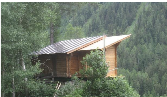
Figura A.58 - Esempio di costruzione in legno per alloggiamento di diverse strumentazioni. Fonte: archivio Attività geologiche – Regione Autonoma Valle d'Aosta
