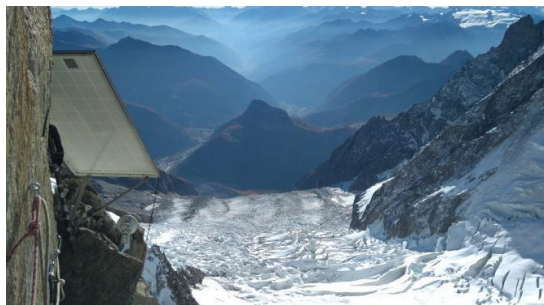
Figura 52 - Esempio di installazione di comunicazione punto-punto in UHF (antenna a parabola bidirezionale in basso) per la trasmissione di dati accelerometrici dalla cresta della Brenva nel Massiccio del Monte Bianco. Fonte: archivio Attività geologiche – Regione Autonoma Valle d'Aosta
