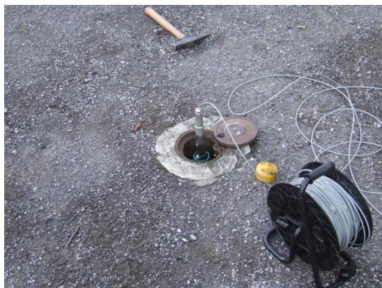
Figura A.30 - Sonda testimone per verifica delle condizioni strutturali della tubazione inclinometrica. Fonte: archivio ARPAL
