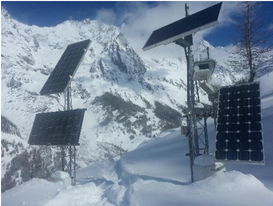
Figura A.52 - Installazione di pannelli fotovoltaici in zona di alta montagna, in cui è presente un notevole carico di neve al suolo. Fonte: archivio Attività geologiche – Regione Autonoma Valle d'Aosta
