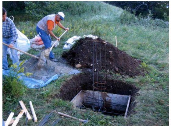
Figura A.9 - Realizzazione pilastro per monitoraggio topografico. Fonte: archivio CMG Arpa Lombardia
