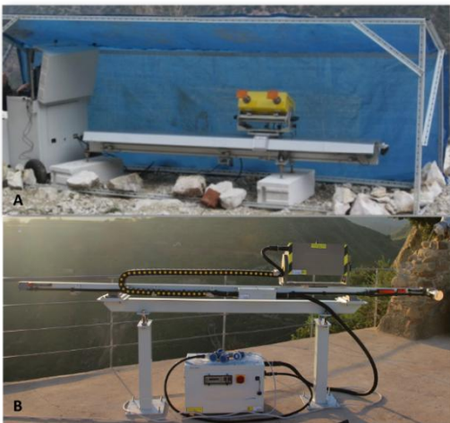
Figura A.15 - Esempi di installazione di sistemi radar ad apertura sintetica (A) su terreno, mediante appoggio su blocchi di calcestruzzo (Fonte: Barla e Antolini, 2016) e (B) mediante montanti ancorati su soletta di cemento (Fonte: archivio UniFi)
