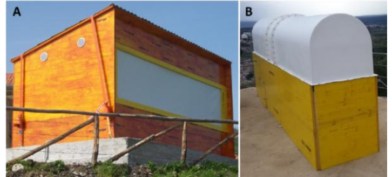
Figura A.16 - Esempi di strutture di protezione della strumentazione. A) casotto con pannello di radome; B) cassone con cupola di radome (Fonte: archivio UniFi)
