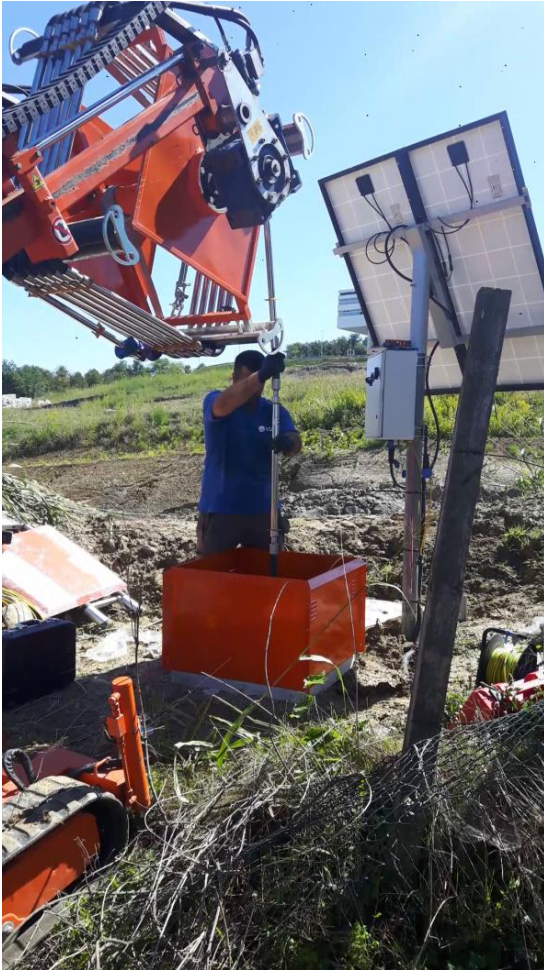
Figura A.35 – Installazione colonna multiparametrica. Fonte: archivio ARPA Piemonte
