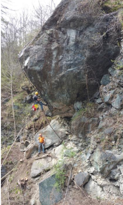
Figura 32 – Operazioni di installazione di una colonna multiparametrica su di un volume roccioso instabile a protezione del cantiere di consolidamento a monte di una strada regionale in Valle d'Aosta (fonte: Regione Valle d'Aosta)
