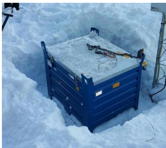
Figura A.55 - Installazione pacco batteria per superare la mancanza di insolazione in zone di alta montagna. Fonte: archivio Attività geologiche – Regione Autonoma Valle d'Aosta
