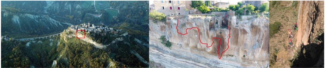
Figura 21 – Sistemi di monitoraggio in fibra ottica installato a Civita di Bagnoregio (VT) nel 2017, per il controllo delle deformazioni associate a potenziali fenomeni di crollo della placca tufacea
