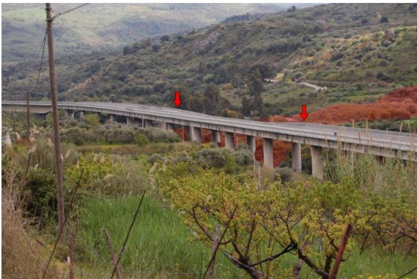
Figura C.45 - Fotografia del viadotto lesionato dalla frana e, retrostante ad esso, una parte della frana del 2015 con retinatura in trasparenza di colore rosso
