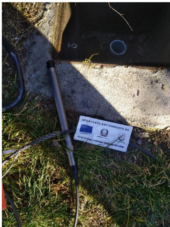
Figura A.43 - Installazione nel piezometro di sonda freatimetrica automatica. Fonte: archivio ARPAL
