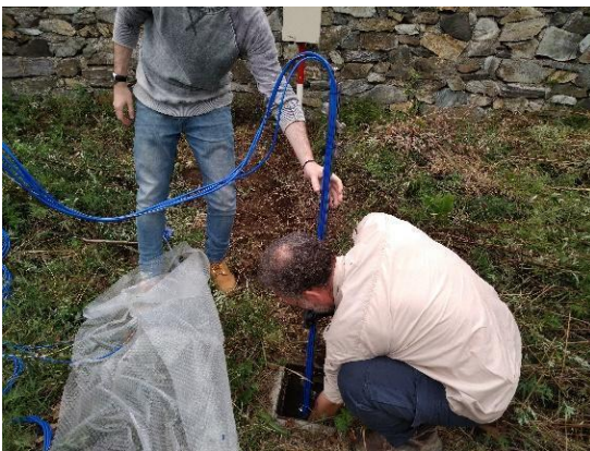
Figura A.34 - Installazione di sonde inclinometriche fisse a profondità identificate dalle campagne di misura inclinometriche manuali. Fonte: archivio ARPAL
