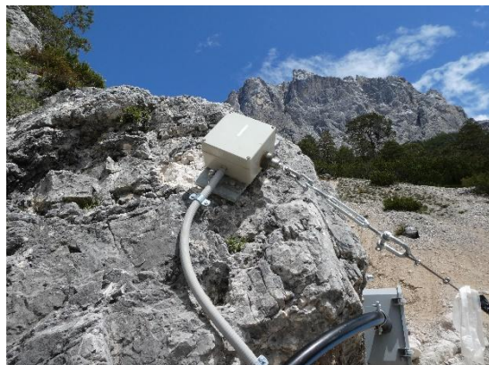
Figura A.24 - Dettaglio dell'installazione di un cavo a strappo: collegamento del cavo all'interruttore sulla sponda in roccia di un canale da colata detritica. Fonte: CNR IRPI
