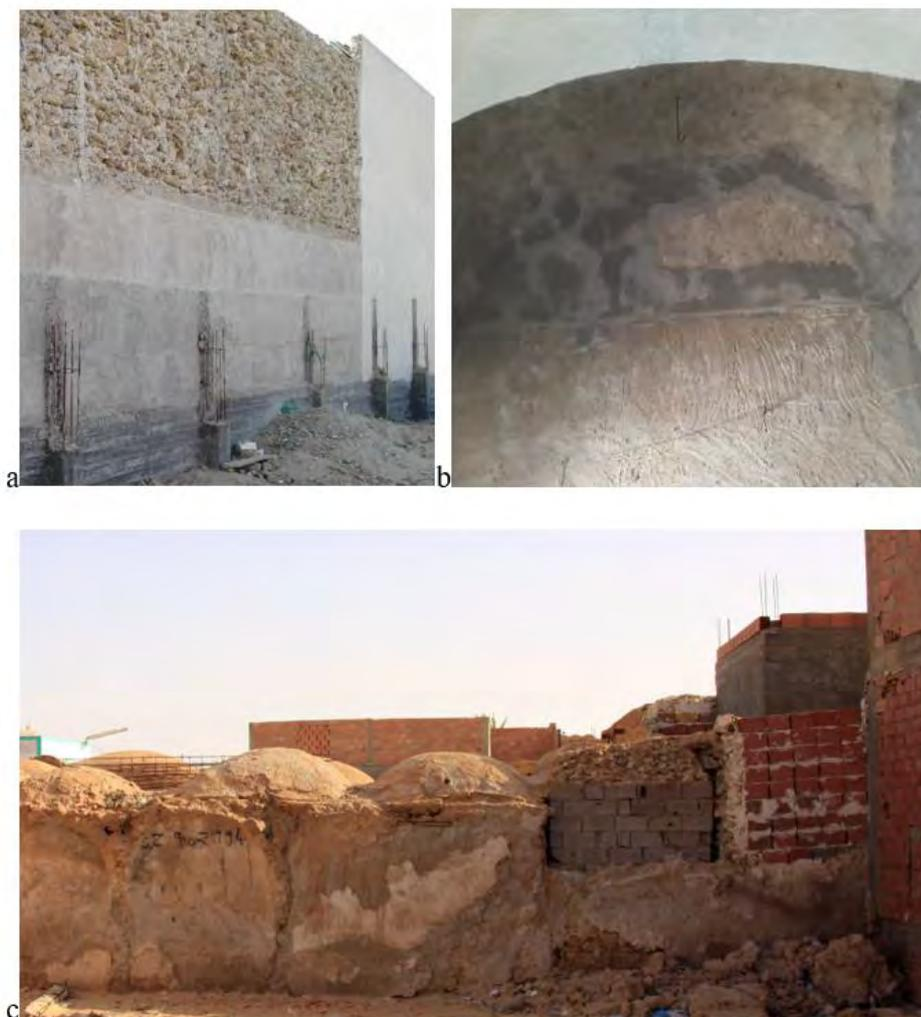
Figure 68. a. Restauration du monument historique Zaouia Ettidjania avec des matériaux industriels, (l'auteure, 2019). b. Réparation des fissures au niveau de la coupole par le ciment, Guemar (l'auteure, 2018). c. Maçonnerie de remplissage (en briques creuses), Guemar (l'auteure, 2019).
