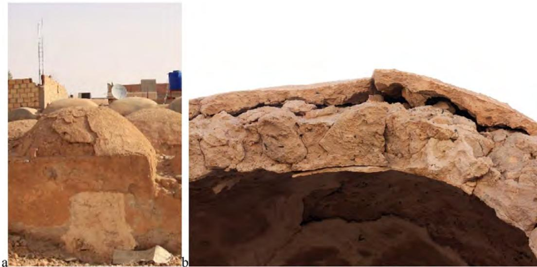
*Figure 85. a & b. Gonflement, détachement et érosion du plâtre dans la couche extérieure des coupoles (l'auteur, 2019).*
