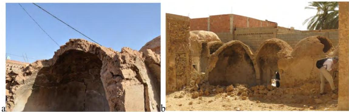
Figure 76. Maisons endommagées à cause de l'effondrement de ses éléments, Guemar (l'auteure, 2019).
