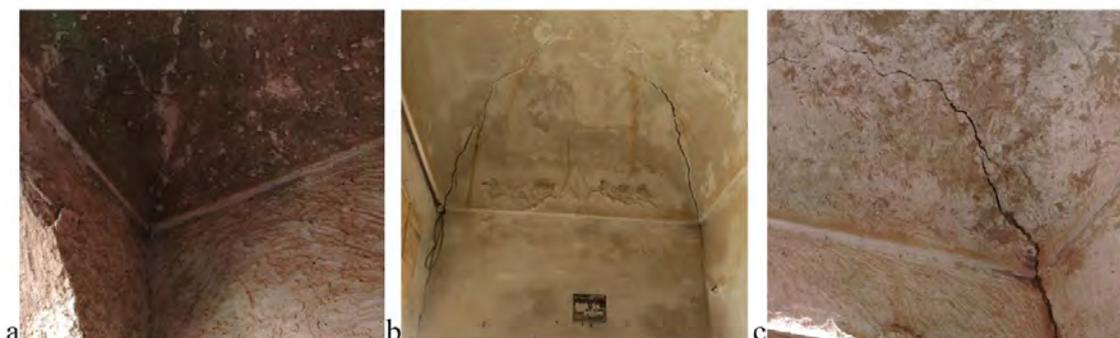
Figure 70.a. Fissure au coin et au diagonal de la coupole (l'auteure, 2019). b. Fractures au coin et au long de diagonales de la coupole (l'auteure, 2019). c. Fracture à l'intersection des parois et au long du diagonal de la coupole (l'auteure,2019).
