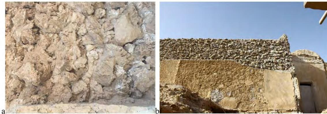
Figure 49. Texture irrégulière d'un mur en blocs de *Rose des Sables* (l'auteure, 2018). b. Mur en *rose des sables*, partie inférieure avec une finition de plâtre. (l'auteure, 2019).
