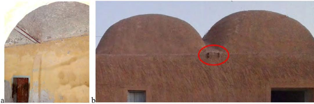
Figure 54. Poutre métallique à la place d'un arc : a. vue intérieure ; b. Vue extérieure (l'auteure : 2019).
