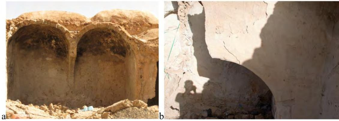
Figure 79. a. Image des effondrements des deux parties des deux coupoles à cause de jointement des fractures selon la figure 78.a (l'auteur, 2019). b. Effondrement des deux parties des deux coupoles passant par la moitié de l'arc de liaison (Giovanni Gubitosa, 2019).
