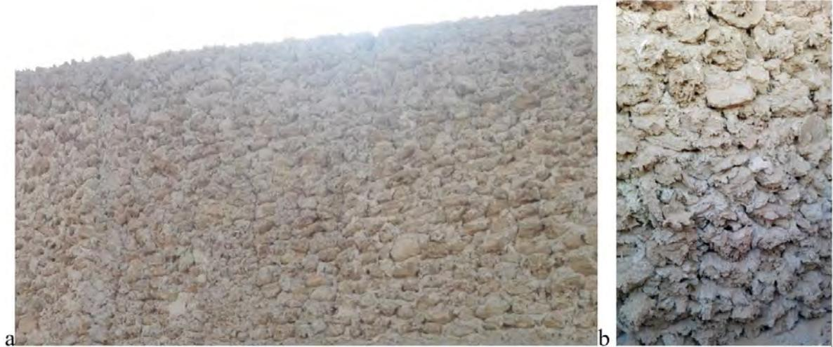
Figure 51. Maçonnerie d'un mur en Rose des Sables et mortier de gypse : a. avant la reprise du mortier ; b. après la reprise du mortier (l'auteure, 2019).
