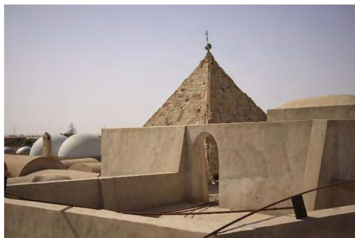
Figure 64. Toiture : plancher plats et pyramide, Zaouïa Ettidjania, Guemar (l'auteure, 2019).
