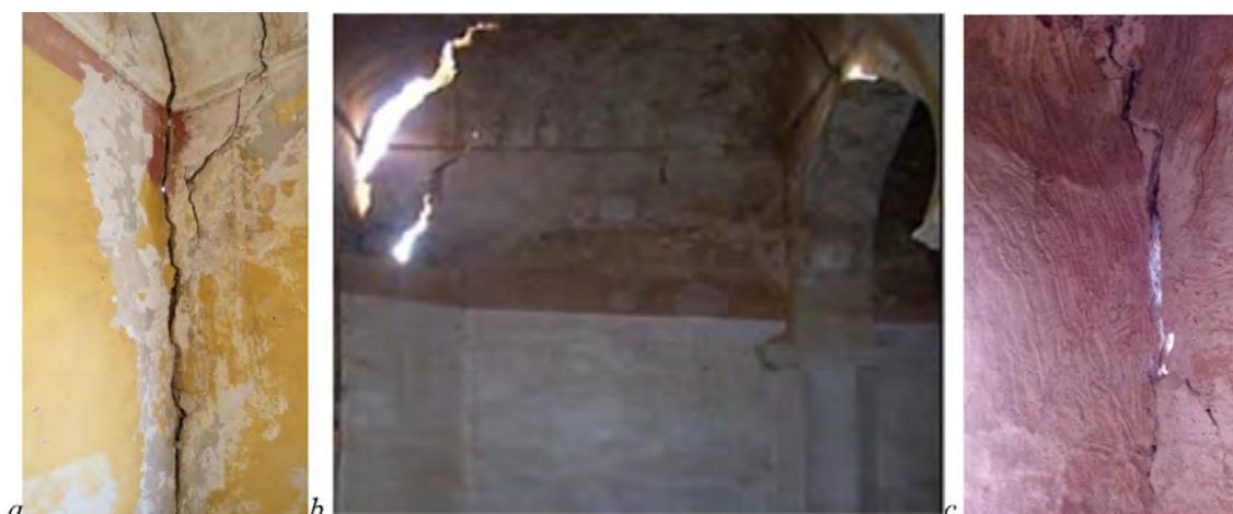
Figure 71. Fractures traversantes et lézards au coin et au long de diagonales de la coupole (Luisa Rovero, 2019).
