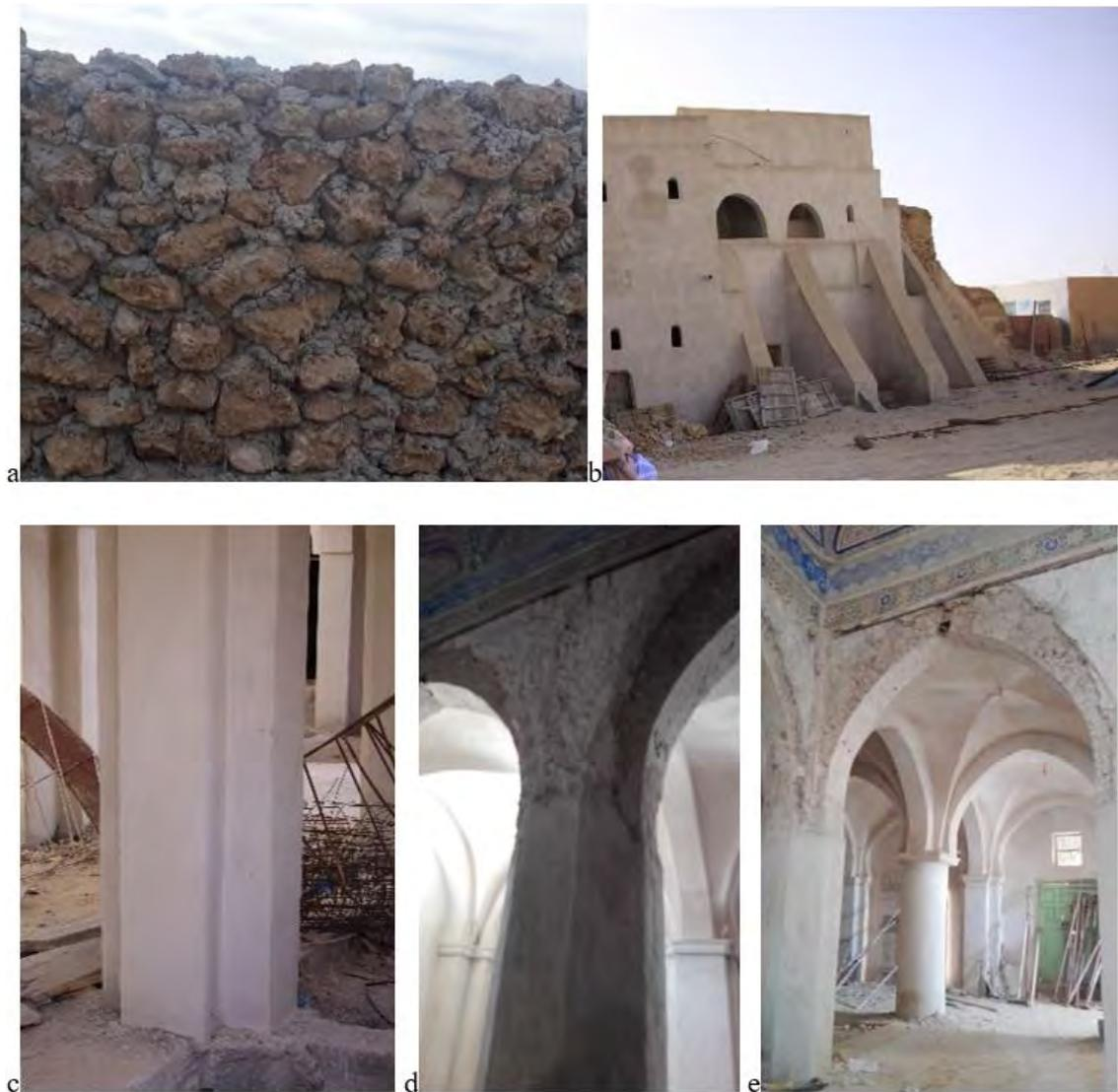
Figure 50. a. Mur de la Zaouia Ettidjania lors la reconstruction, avec des grands blocs de la pierre de la Rose des Sables (l'auteure, 2018). b. Contreforts dans la façade externe de la Zaouia Ettidjania (l'auteure, 2019). c. Pilier croisé en Rose des Sables, Zaouïa Ettidjania, Guemar. d. Pilier octogonal en Rose des Sables, Zaouïa Ettidjania, Guemar. e. Colonne en Rose des Sables, Zaouïa Ettidjania, (l'auteure, 2019).
