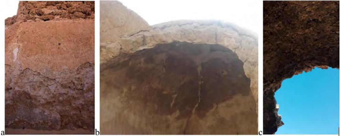
Figure 86. Moisissures et efflorescences : a. Au niveau de la base des murs ; b & c. Au niveau de l'intrados de la coupole (l'auteure, 2019).
