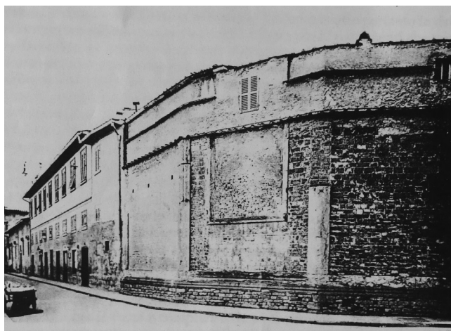
Fig. 10. Foto del 1930 circa della Rotonda del Brunelleschi nell'angolo tra via degli Alfani e via del Castellaccio prima dei lavori di rifacimento.
