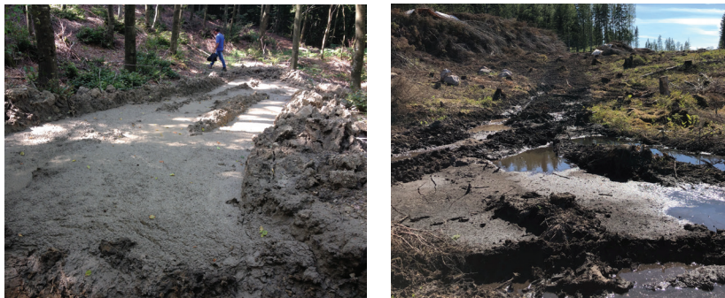
Figura 24: Colate di fango (sinistra) e ristagno idrico (destra) formati in seguito a forte pioggia in un cantiere forestale
