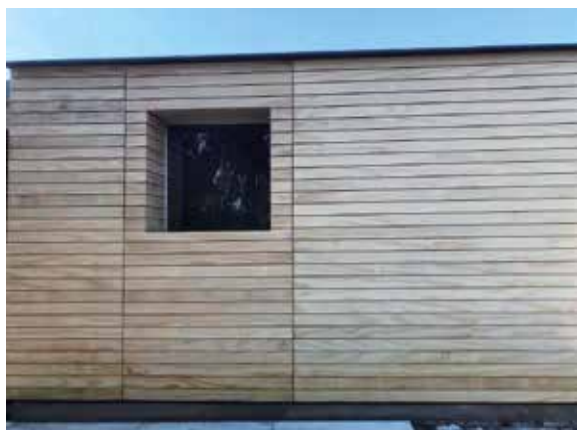
Figura 26. Prova di applicazione della facciata a schermo avanzato con rivestimento ligneo (realizzata da Arredoline Costruzioni S.R.L.).
