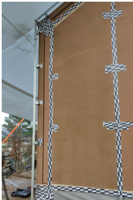
Fig.68 - Completamento del sistema tecnologico: sigillatura dei giunti e integrazione della sotto-struttura per il tensionamento del telo plastico di rivestimento esterno (Credits: © Archicart®)
