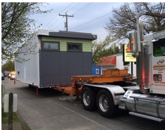
Fig.62 - Le unità modulari sono completate off-site fino ad un grado di pre-assemblaggio del 90%, riducendo le operazioni in sito alla sola connessione e sigillatura dei giunti tra i moduli (Credits: SEED Collaborative da https://inhabitat.com/modular-net-zero-net-energy-seed-classroom-to-debut-in-pittsburg/seed-classroom-seed-collaborative-3/ )
