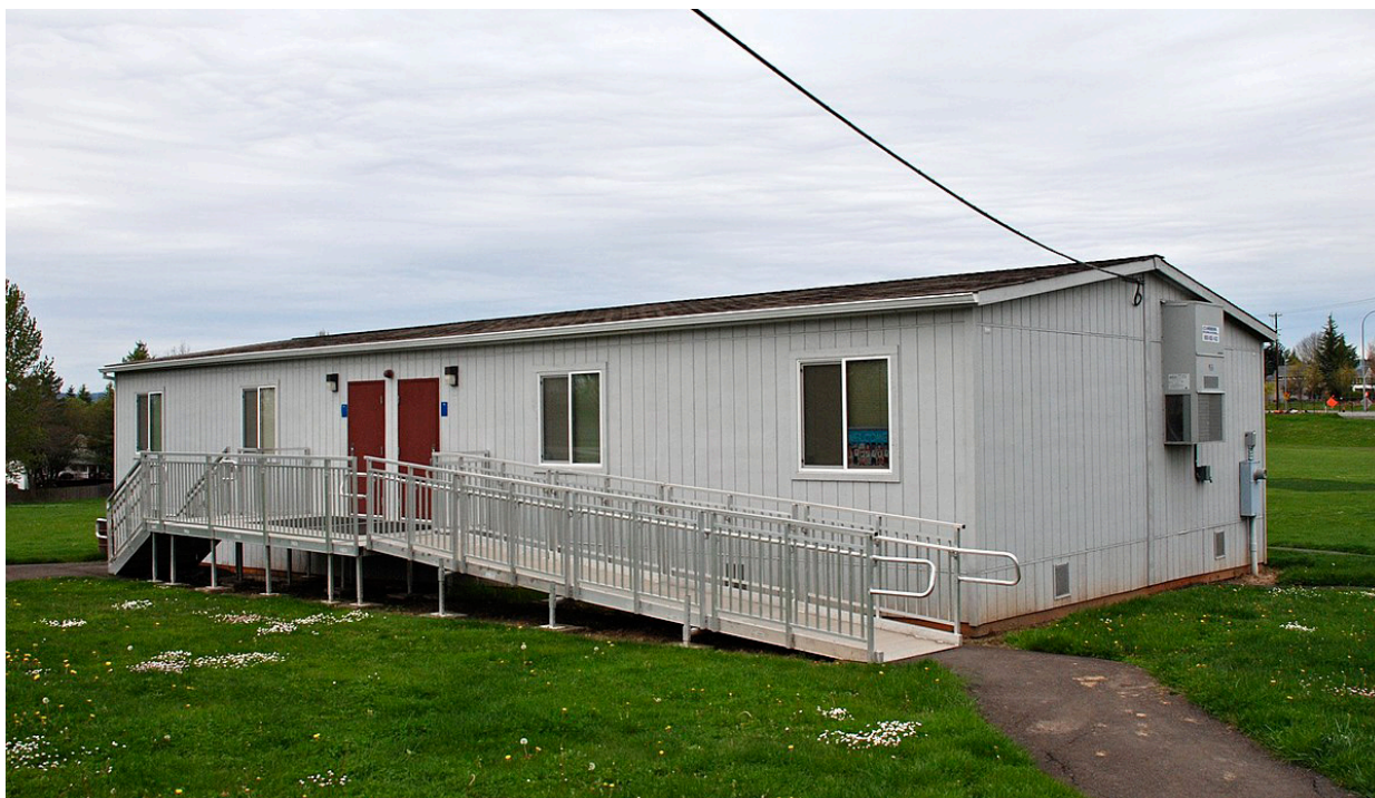
Fig.23 - Un esempio di portable classroom installata presso la Rock Creek Elementary School (Washington County, Oregon, USA) per gestire l'emergenza dovuta al sovraffollamento scolastico (Credits: © Steve Morgan, 2012 da commons.wikimedia.org (Creative Commons Licence))
