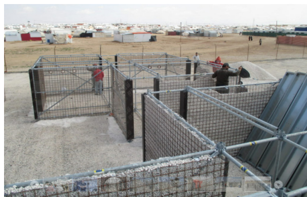
Fig.38 - Il sistema costruttivo sviluppato nell'ambito del programma Rebuild utilizzato per la realizzazione di due edifici del Makani Remedial Educational Center (2016) nel campo Za'atari in Giordania (Credits: Foto Tassotto&Max © Building Peace Foundation)
