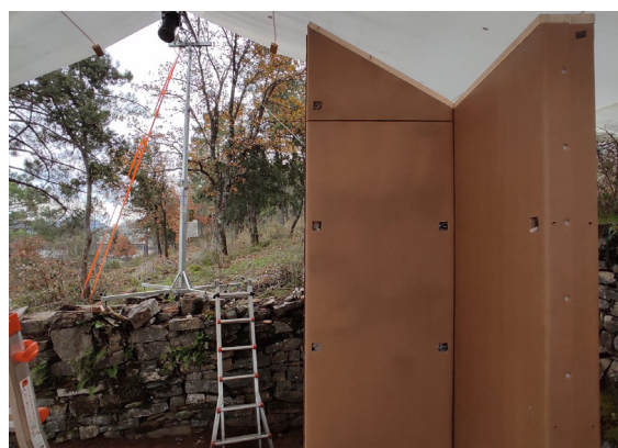
Fig.129 - Messa in opera dei pannelli prefabbricati in cartone (Credits: Foto personale, 2020)
