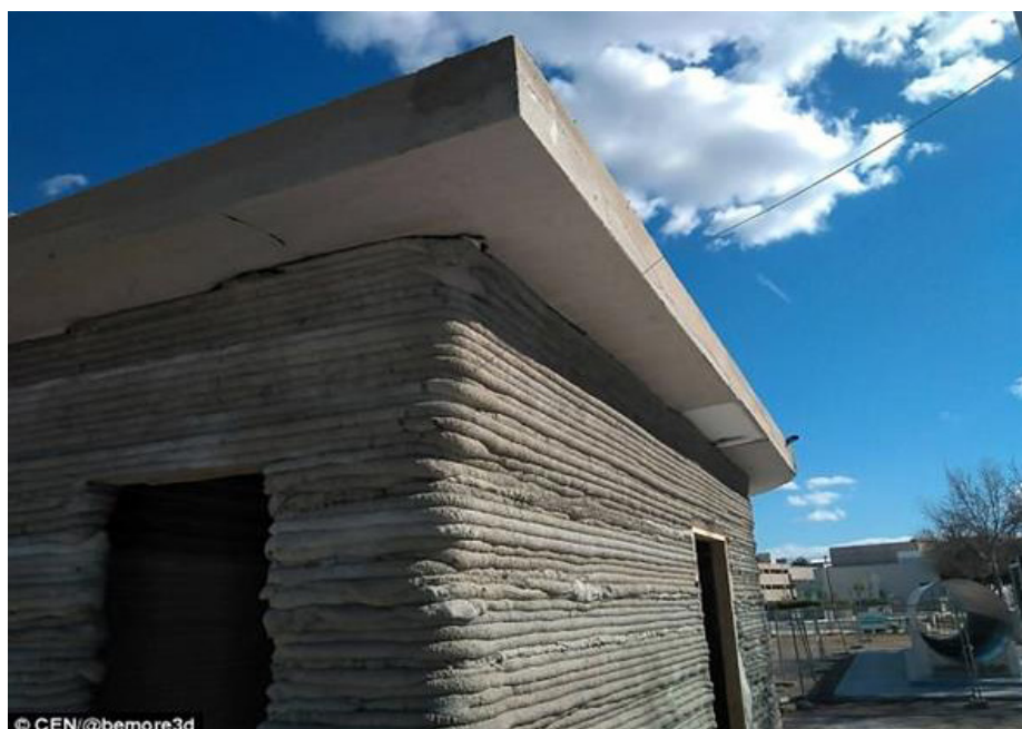
Fig.49 - Edificio realizzato con la tecnica della stampa 3D in calcestruzzo (Credits: © CEN@bemore3d)
