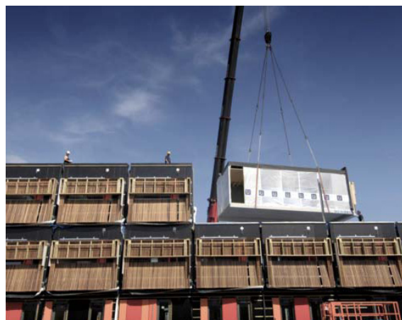
Fig.84 - L'utilizzo di unità prefabbricate ha consentito di ridurre sostanzialmente i tempi di messa in opera rispetto a tecniche tradizionali, rendendo l'edificio disponibile in tempo utile all'inizio dell'attività scolastica (Credits: Foto di © Lorenzo Calistri, HVDN architecten design team (Albert Herder, Arie van der Neut) da www.indire.com )
