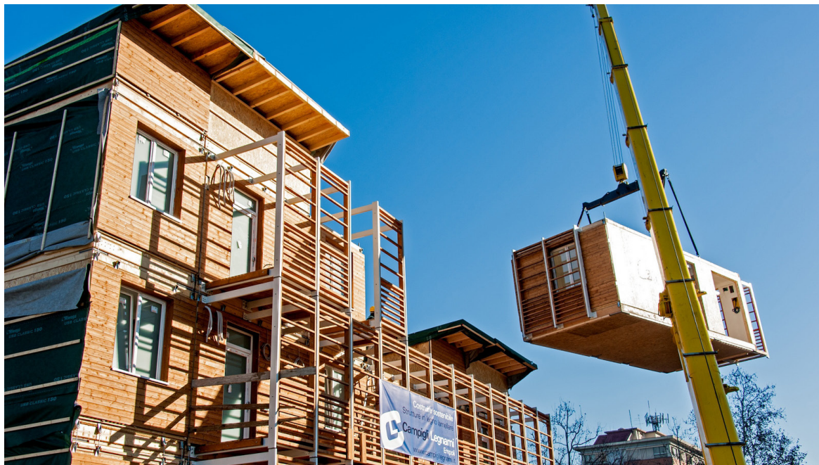
Fig.86 - Unità modulari in platform frame utilizzate per la realizzazione di 18 alloggi ERP a Firenze (Casa Spa/Campigli Legnami, 2013) (Credits: Campigli Legnami da www.campiglilegnami.it )
