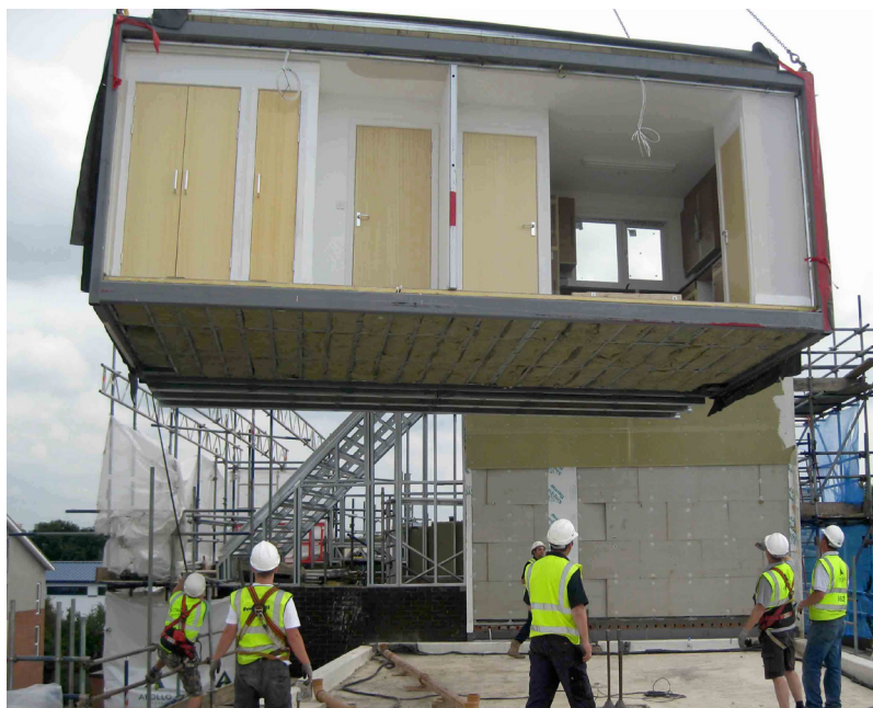
Fig.38 - Sistema costruttivo a unità volumetriche tridimensionali prefabbricate (Credits: Hamarks: www.hamarks.co.uk )
