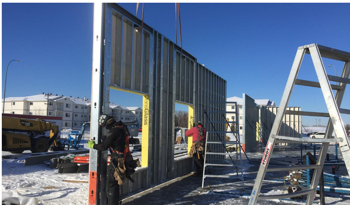
Fig.105 - Pannelli prefabbricati con struttura a telaio leggero in acciaio (Credits: Lightweight Building Systems, Inc. da lwbsi.com)
