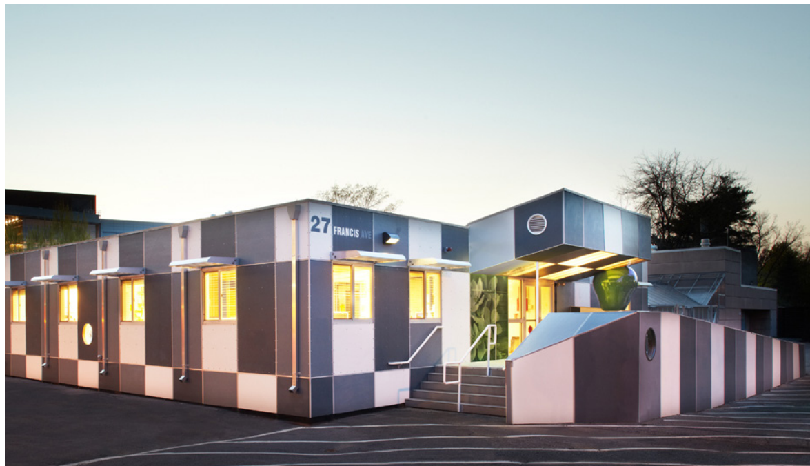
Fig.79 - Vista dell'Harvard Yard Child Care Center, realizzato attraverso moduli prefabbricati in un'area destinata a parcheggio all'interno del campus dell'Harvard University (Credits: Triumph Modular da www.triumphmodular.com )
