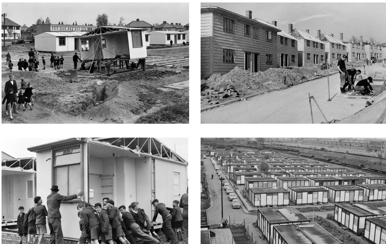
Fig.15 - Temporary Housing Programme nel Regno Unito: realizzazione di unità abitative post-belliche attraverso sistemi prefabbricati (1945-1949) (Credits: © Hulton Deutsch/Corbis/Getty/Keystone Features/Evening Standard da www.theguardian.com)
