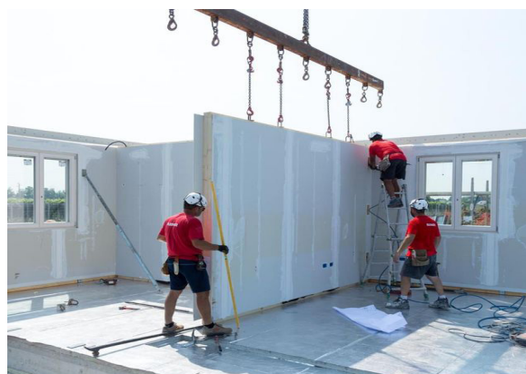
Fig.11 - Installazione in cantiere di pannelli prefabbricati (Credits: Rubner: www.rubner.com)
