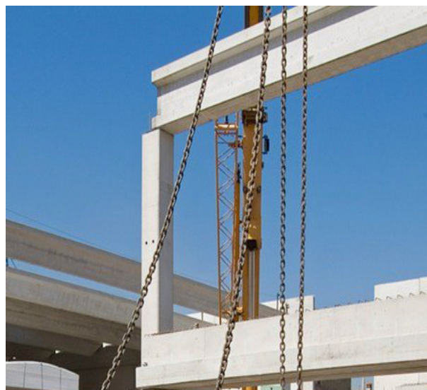
Fig.40 - Sistema costruttivo a elementi lineari prefabbricati (telaio) (Credits: Premac Prefabbricati da archiproducts.com )
