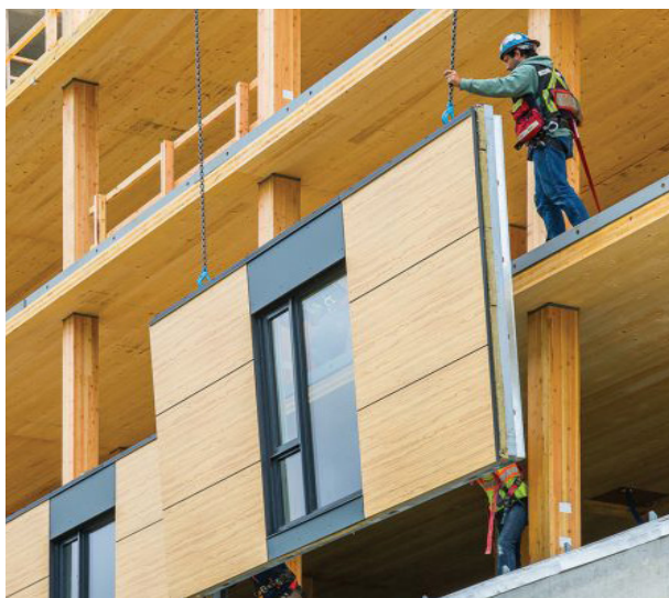
Fig.41 - Sistemi e componenti prefabbricati non strutturali (MMC Categoria 5) (Credits: © Acton Ostry Architects Inc. and University of British Columbia)
