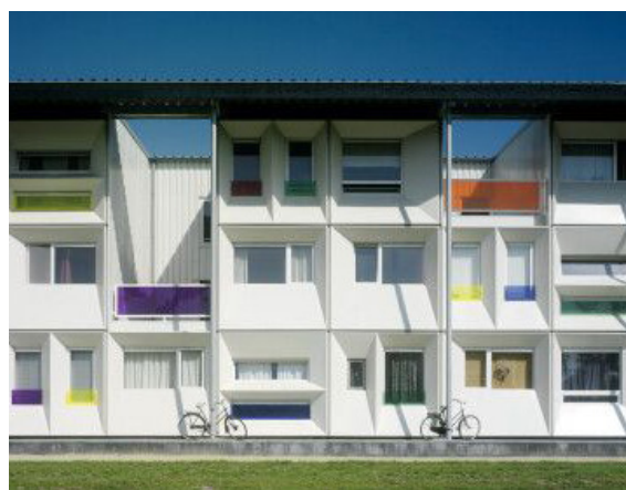
Fig.80 - Progetto dello studentato Qubic, realizzato aggregando container ISO (Stunionedots, 2005) (Credits: © Luuk Kramer)
