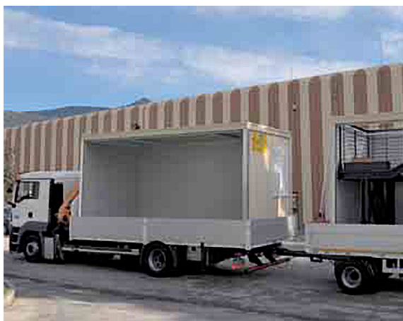
Fig.68 - Le unità modulari sono state pre-assemblate in officina e trasportate in sito per l'installazione e il completamento in opera degli infissi e finiture (Credits: © Fae Terni S.p.a da www.faeterni.it )
