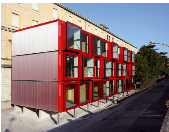
Fig.79 - Edificio temporaneo per il Campus Point a Lecco, realizzato attraverso container ISO opportunamente modificati (Studio Ar.De.A di A.Montanelli, 2007-2013) (Credits: © Studio Ar.De.A. )
