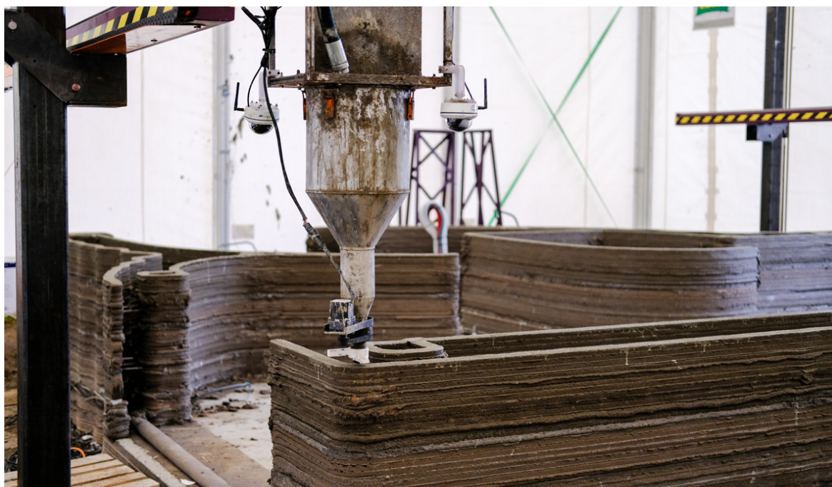
Fig.130 - Stampa 3D di strutture monolitiche continue (Credits: © COBOD da cobod.com)
