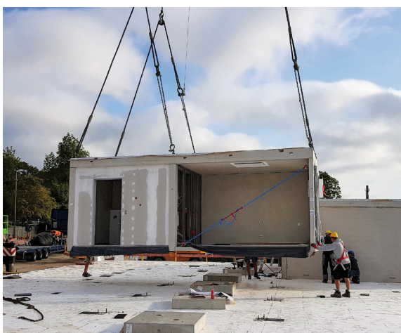
Fig.98 - Le fasi di sollevamento e installazione in sito possono comportare oneri aggiuntivi in considerazione del peso elevato delle strutture (Credits: Solidbox)
