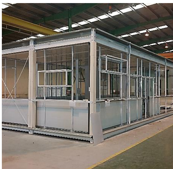
Fig.73 - Aggregazione della struttura delle unità modulari all'interno dell'officina (Credits: Algeco S.p.a. da algeco.it)
