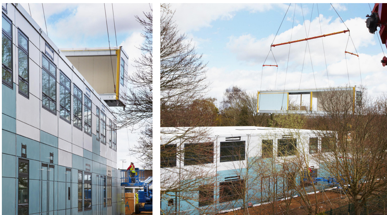
Fig.33 - La Yorkon Pyrford Primary School è una delle scuole realizzate nell'ambito del PSBP (2015) (Credits: © Mott MacDonald)
