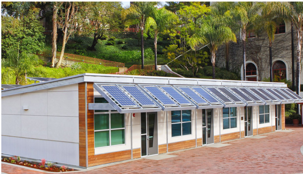
Fig.73 - Il modello di Gen7School installato nel cortile della Brentwood School a Los Angeles (CA, USA) (Credits: © American Modular System™ da www.americanmodular.com )
