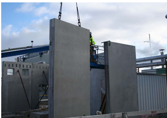
Fig.123 - Fasi di movimentazione in sito per la messa in opera dei pannelli (Credits: Huff Cutt da huffcutt.com)
