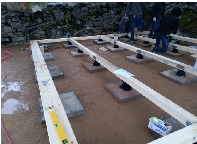
Fig.67 - Esempio di sistema di attacco a terra reversibile, realizzato attraverso appoggi puntuali prefabbricati e regolabili (Credits: Foto personale, 2020)
