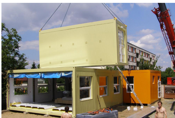
Fig.10 - Fasi di messa in opera di unità modulari prefabbricate (Credits: Koma Modular Construction s.r.o. da commons.wikimedia.org (Creative Commons Licence))
