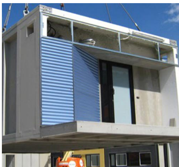
Fig.96 - Le unità modulari possono essere completate off-site con sistemi di rivestimento e chiusura (Credits: Compact Habit® da www.compacthabit.com )
