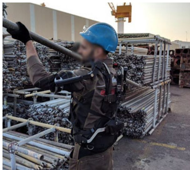
Fig.42 - Esoscheletri utilizzati durante le fasi di movimentazione dei componenti e messa in opera per migliorare la sicurezza e salute degli operatori (MMC Categoria 7) (Credits: BiBlus BIM: bim.acca.it)
