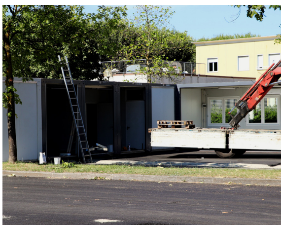
Fig.47 - Fasi di installazione dei moduli prefabbricati in sito (Credits: Provincia di Lucca, 2018 da www.provincia.lucca.it )
