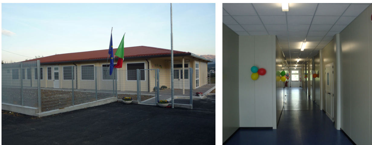
Fig.24 - Una scuola prefabbricata realizzata a L'Aquila con moduli containerizzati per la gestione del post-sisma del 2009 (Credits: Modulcasaline)
