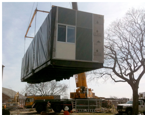
Fig.81 - Le unità modulari sono state pre-assemblate e completate in officina, quindi trasportate in sito per l'installazione (Credits: © Anderson Anderson Architecture)
