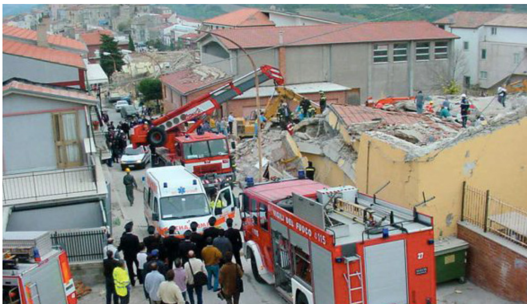
Fig.21 - Il crollo della Scuola Jovine di San Giuliano di Puglia (2002) a seguito del sisma in Molise testimonia la profonda vulnerabilità delle strutture scolastiche nei confronti di eventi naturali catastrofici (Credits: www.primopianomolise.it )
