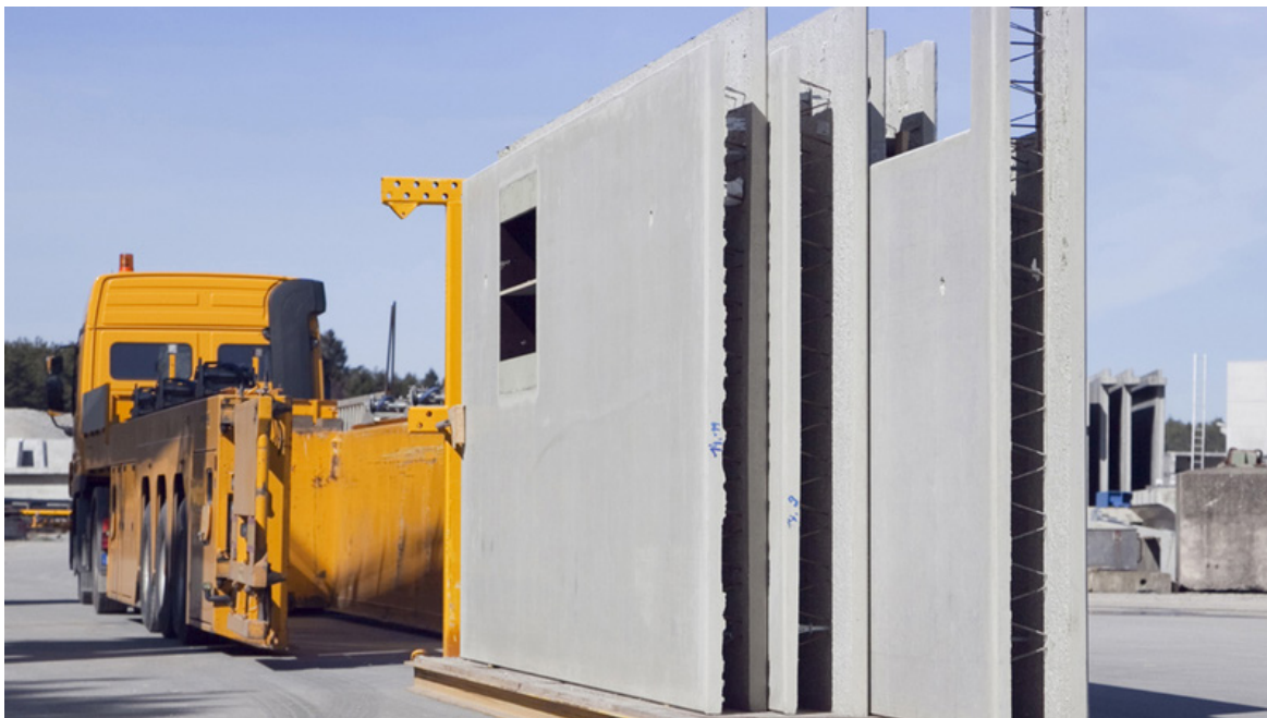
Fig.120 - Pannelli prefabbricati in calcestruzzo con tecnologia a intercapedine tralicciata in acciaio (Credits: Detail da https://www.detail.de/artikel/betonfertigteile-im-hochbau-8791/ )
