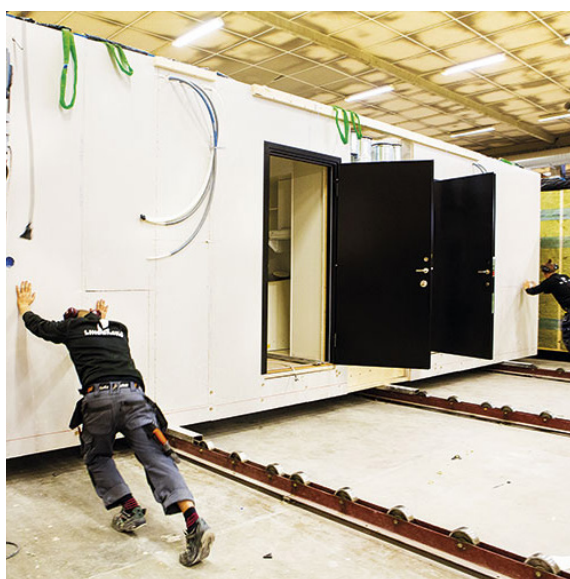
Fig.87 - Catena di produzione off-site industrializzata di unità modulari in legno (Credits: © Charlotta von Schultz da www.elinstallatoren.se )
