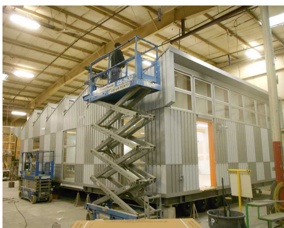
Fig.59 - Le unità prefabbricate della Energy-Positive Relocatable Classroom vengono pre-assemblate e finite all'interno della fabbrica (Credits: © Anderson Anderson Architecture da www.architizer.com )
