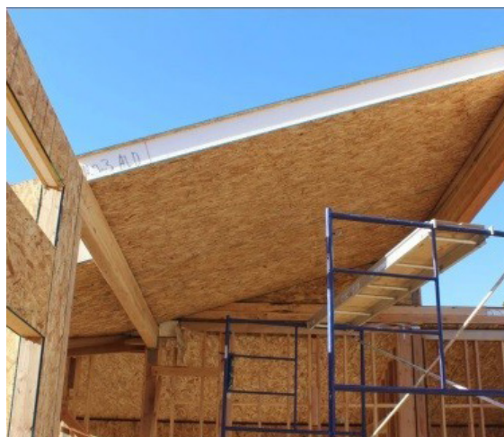
Fig.104 - Installazione di pannelli SIP in combinazione con una struttura a telaio in legno (Credits: Morn da www.mornglass.com)
