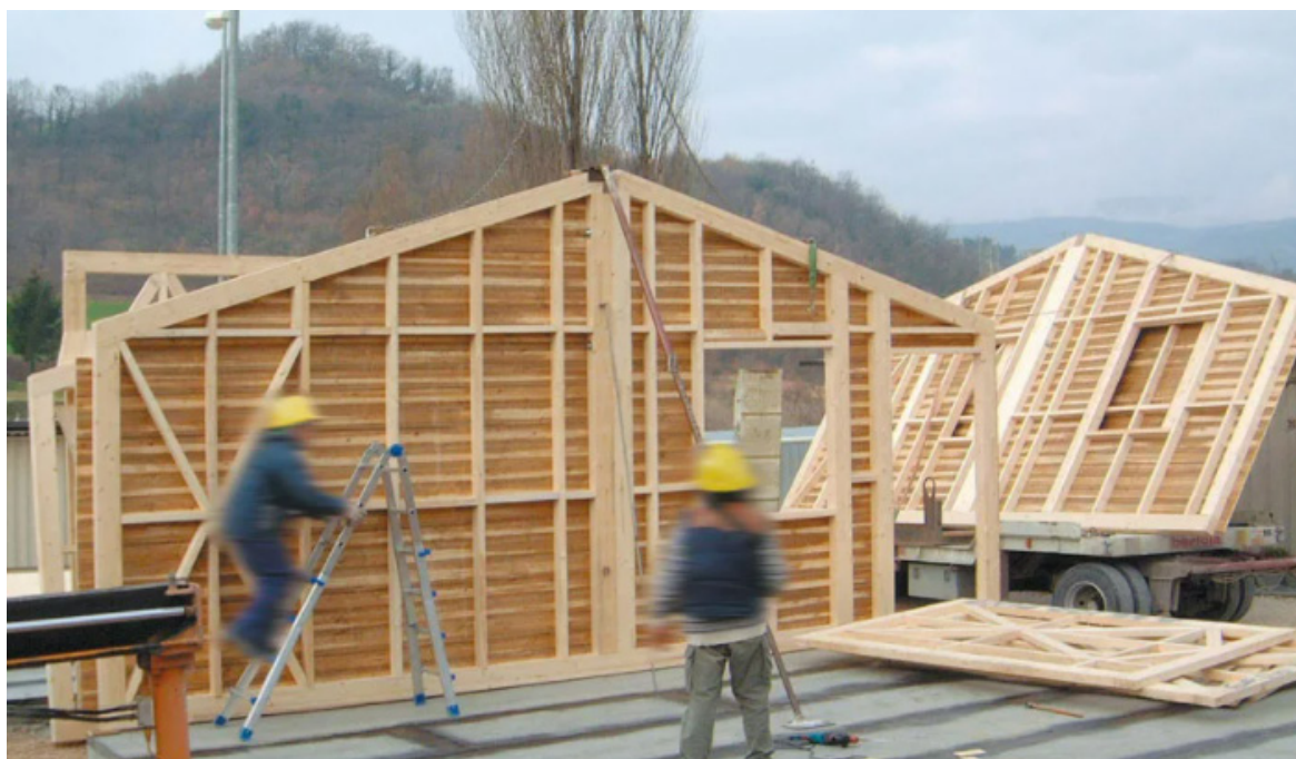
Fig.110 - Pannelli prefabbricati con struttura a telaio leggero in legno (Credits: Costantini Legno da www.costantinilegno.it )
