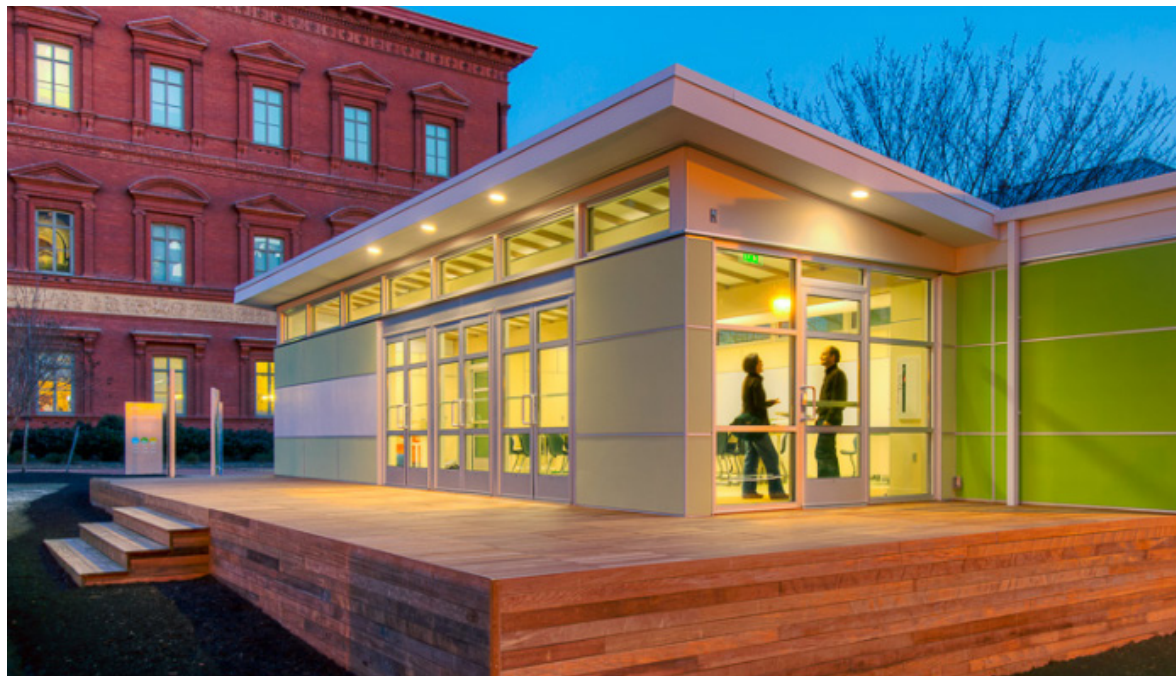
Fig.64 - Il prototipo Sprout Space installato nel cortile del National Building Museum a Washington D.C. (USA) (Credits: © 2022 Perkins+Will da www.sproutspace.com )
