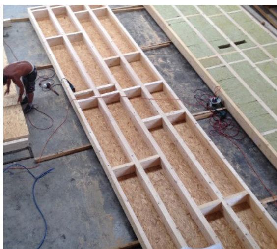
Fig.112 - Fasi di completamento off-site dei pannelli (Credits: Ecomotti da www.ecomotti.it )
