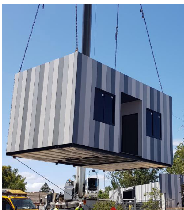
Fig.34 - Unità modulari prefabbricate utilizzate per la realizzazione di interventi di edilizia scolastica nell'ambito del programma PMSB (Credits: University of Melbourne: https://pursuit.unimelb.edu.au/articles/building-the-prefab-schools-of-the-future )
