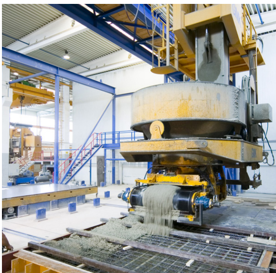
Fig.121 - Fasi di produzione off-site dei pannelli prefabbricati attraverso il getto in casseforme riutilizzabili (Credits: Detail da https://www.detail.de/artikel/betonfertigteile-im-hochbau-8791/ )
