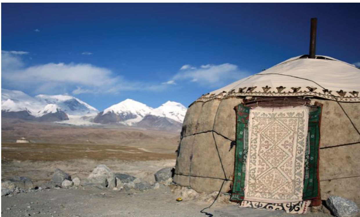
Fig.28 - La jurta è un archetipo di architettura nomade improntata a principi di trasportabilità, assemblabilità e dismessibilità ciclica, ancora in uso presso le comunità mongole e kirgise (Credits: © Stefano Tronci/Shutterstock.com)
