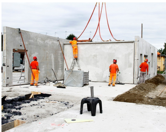
Fig.71 - I pannelli in calcestruzzo sono stati pre-assemblati in officina e trasportati in cantiere per l'installazione, dopodiché completati con le opere di finitura (Credits: © Veronica Santadrea per MCA)
