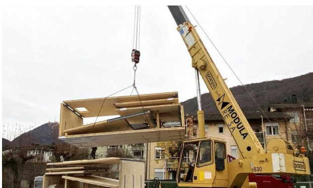
Fig.94- Per ottimizzare e ridurre l'impatto delle fasi di trasporto, possono essere impiegate soluzioni pop-up dispiegabili come quella del modello MADI Home (Credits: MadiHome da madihome.com)
