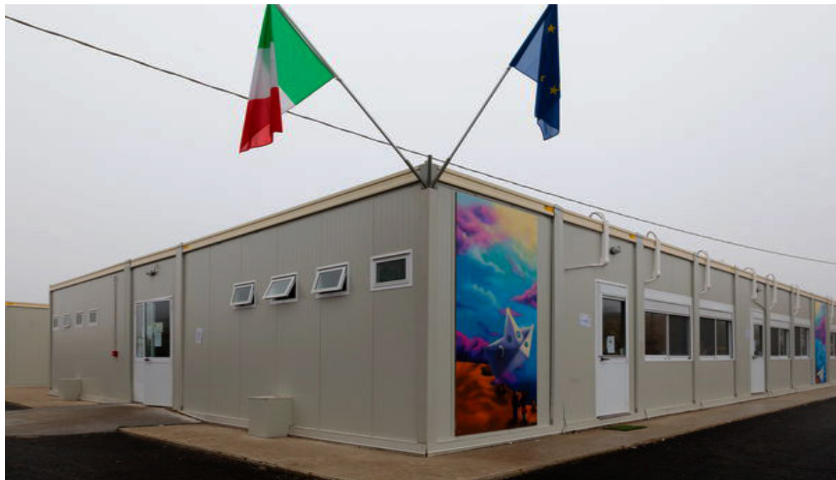
Fig.67 - Vista esterna della scuola "M. Malpighi" realizzata a seguito del terremoto in Emilia Romagna del 2012 (Credits: Courtesy © Fae Terni S.p.a)
