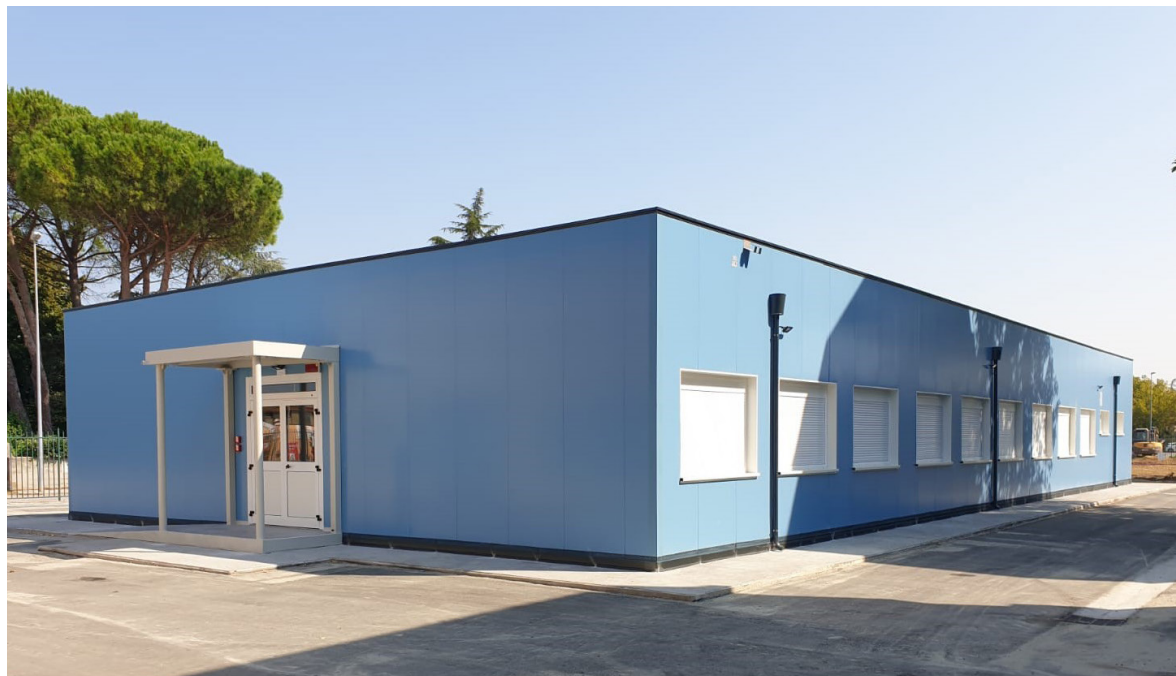
Fig.43 - Vista esterna dell'ampliamento del Campus scolastico di Pontedera realizzato attraverso l'installazione di unità modulari pre-assemblate (Credits: Modulcasaline: www.modulcasaline.com )
