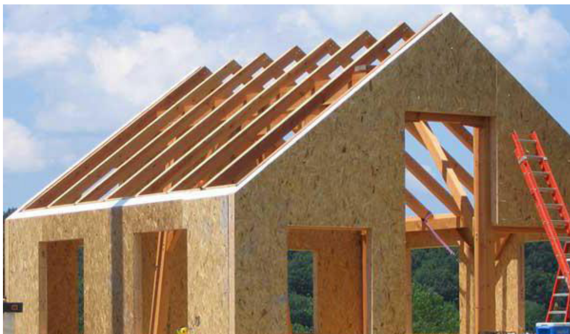
Fig.100 - Edificio realizzato con pannelli prefabbricati SIP (Credits: ERCH2014 da it.erch2014.com)
