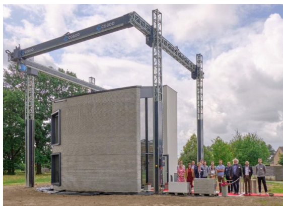
Fig.134 - L'edificio più grande stampato in 3D attraverso una stampa singola continua (Credits: © Kamp C)
