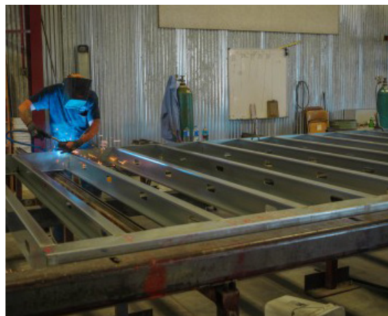
Fig.109 - L'assemblaggio off-site dei profili permette di operare un maggior controllo sulla qualità finale del prodotto e di garantire maggior sicurezza per gli operatori (Credits: Drywall Systems Plus)
