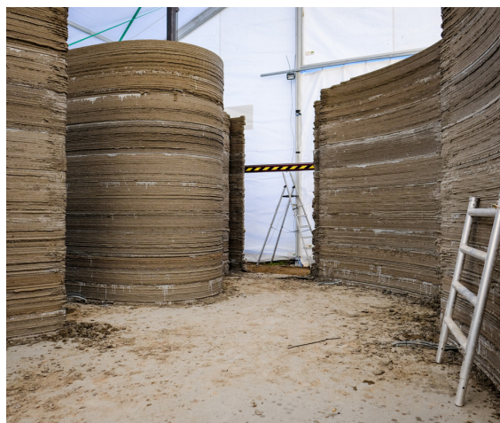
Fig.132 - Completamento della struttura portante dell'edificio (Credits: © COBOD da cobod.com)
