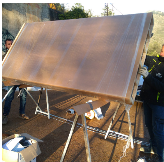
Fig.127 - La leggerezza dei pannelli ne rende possibile la movimentazione da parte di due operatori (Credits: Foto personale, 2020)
