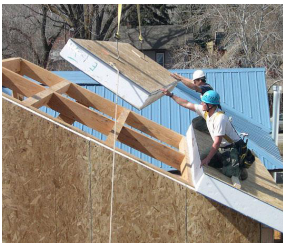
Fig.103 - La leggerezza e facilità di movimentazione dei pannelli ne rendono possibile la messa in opera da parte di un numero ridotto di operatori (Credits: Hobotec da it.hoboetc.com)
