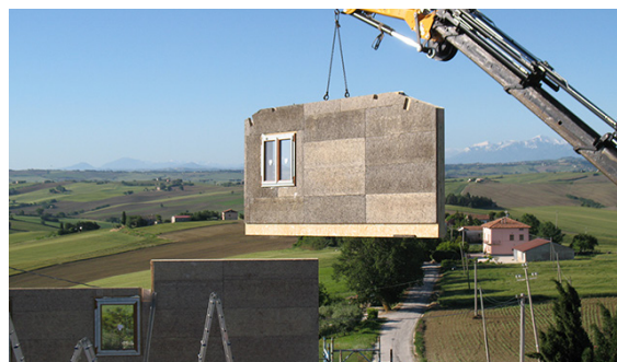
Fig.114 - Installazione di pannelli pre-assemblati con gli elementi di finitura e completamento (Credits: Subissati da subissati.it )
