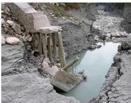
Fig. 1 - Particolari degli effetti dell'erosione in alveo nel F. Vomano.
