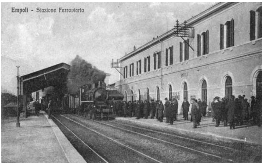
La Stazione Leopolda ha ormai assorbito quella della Strada Ferrata Centrale Toscana, la cui tettoia appare qui demolita.
