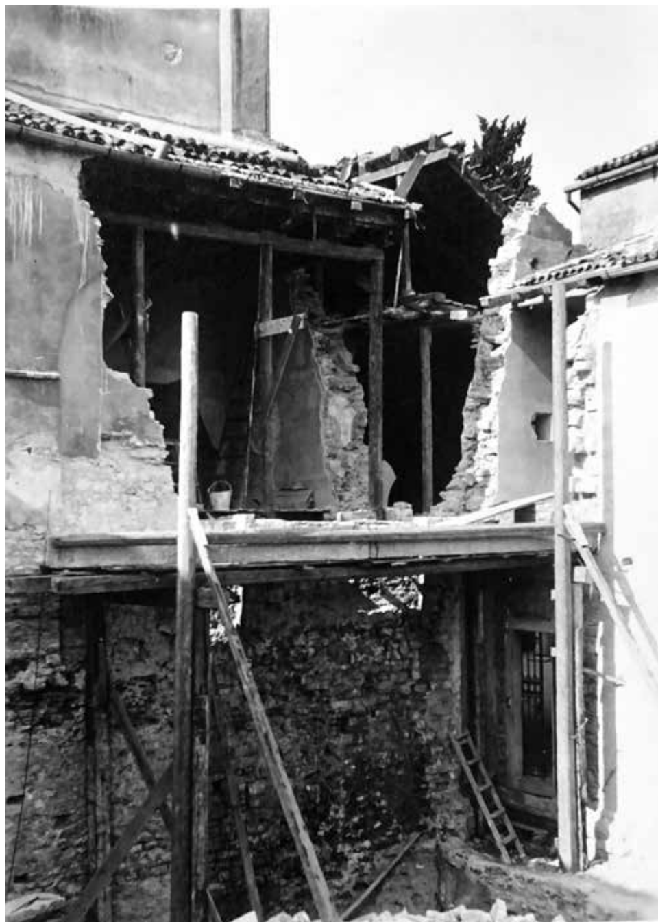
Parenzo, basilica Eufrasiana, sistemazione del lato sinistro con abbattimento di alcune porzioni ammalorate, 1928 (da Roma, ACS,AA.BB.AA., Div.II, b. 260)
