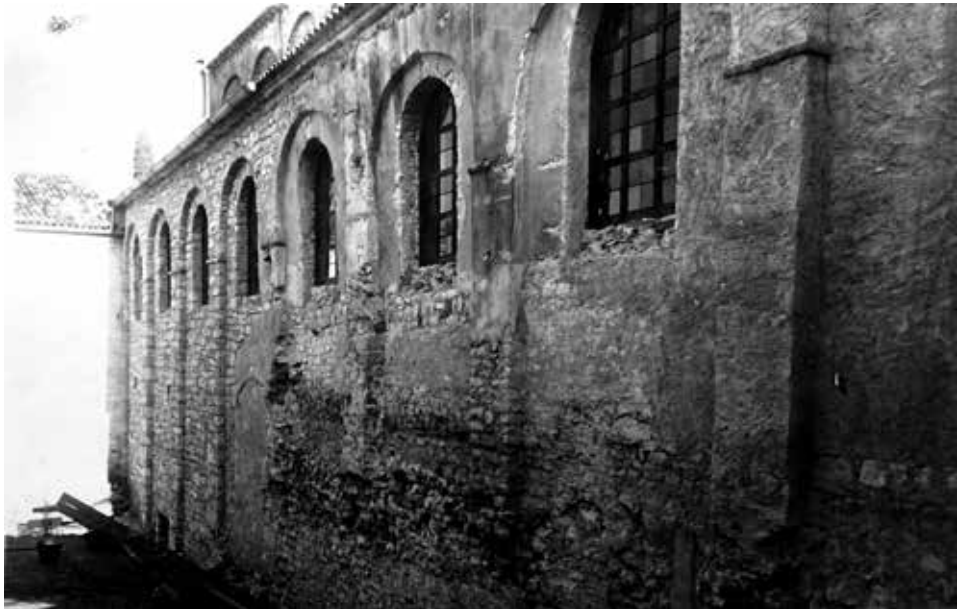
Parenzo, basilica Eufrasiana, stato delle murature in elevato, 1930 (da Roma, ACS, AA. BB.AA., Div.II, b. 288)
