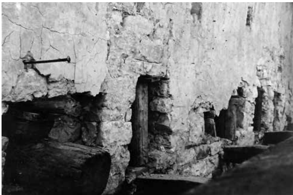
Parenzo, basilica Eufrasiana, 6. 1928, lato sinistro della navata centrale, particolare delle murature, 1928 (da Roma, ACS, AA.BB.AA., Div.II, b. 288)
