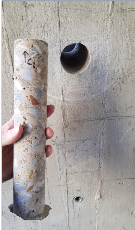
Figura 3.13. Sorgane, edificio A, Pilastro P16. Il provino è stato carotato in corrispondenza dell'area di prova A-A'.
