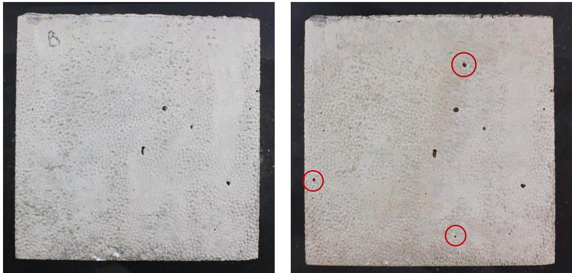
Figura 5.3. Deterioramento tipo delle superfici del provino al termine della prova di invecchiamento con cicli di gelo/disgelo. A sx il provino 26II, lato B, prima della prova; a dx dopo 56 cicli di gelo/disgelo. Al termine della prova si riscontra un accentuarsi delle porosità superficiali già esistenti e la formazione di alcune nuove porosità (in evidenza), mentre non sono riscontrabili fratture e/o fenomeni di scaling .
