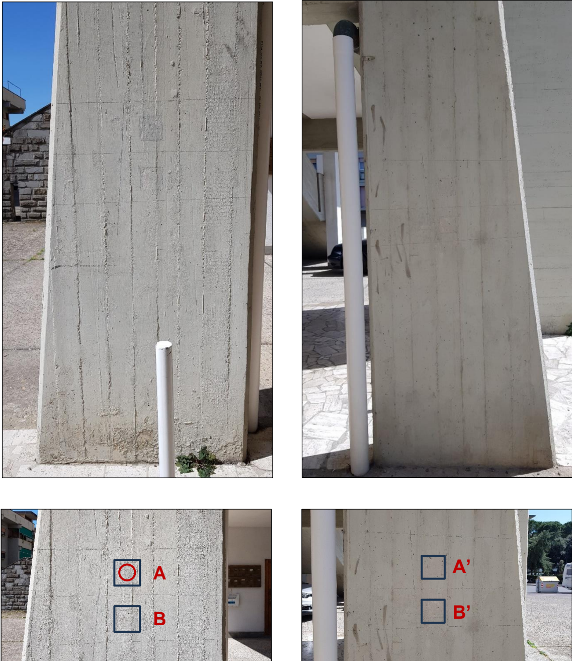
Figura 3.12. Sorgane, edificio A, Pilastro P69. Sopra: Prospetti AB e A'B' con il rilievo delle armature eseguito mediante pacometro; sotto: dettaglio delle aree di indagine A e B e delle corrispondenti A' e B', per l'esecuzione delle misure in trasmissione diretta.
