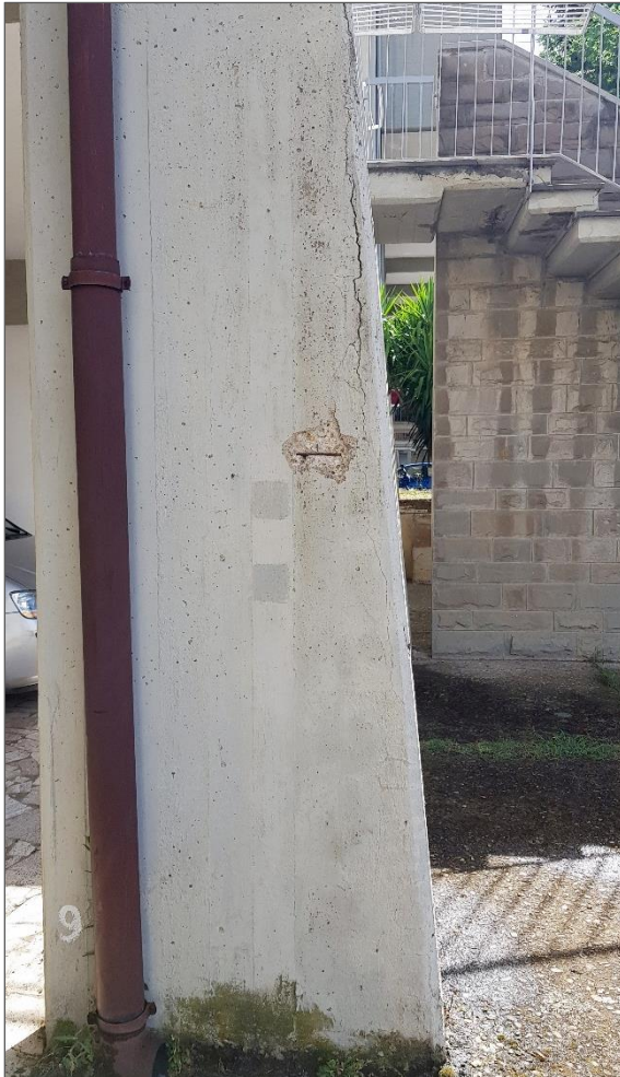
Figura 3.6. Dettaglio dei segni di deterioramento sui pilastri del terzo blocco, lato sud, maggiormente esposti alle piogge battenti.
