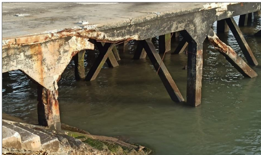
Figura 2.7. Esempio di struttura in c.a. in ambiente marino, in parte permanente sommersa, in parte sottoposta a bagnatura ciclica in corrispondenza delle tidal and splash zones .
