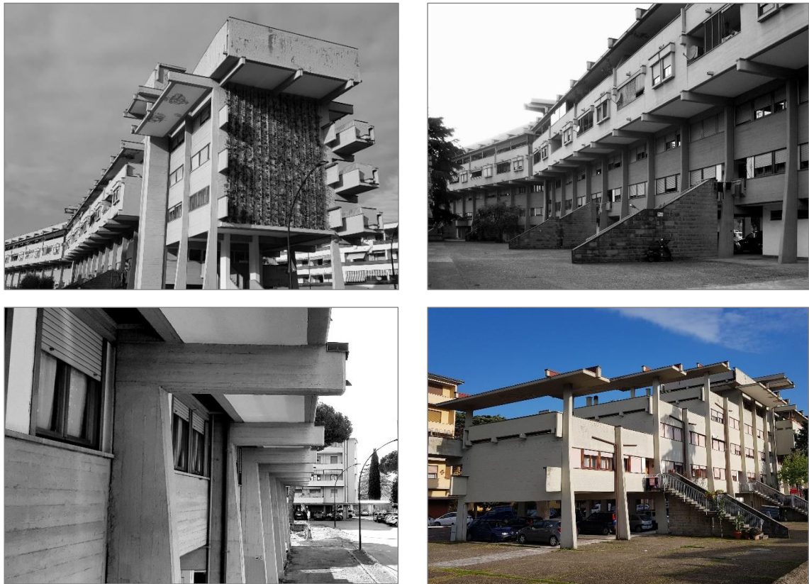
Figura 3.2. Sorgane, edificio A (1981). Vedute dei prospetti (foto M. Castellini, 2021).
