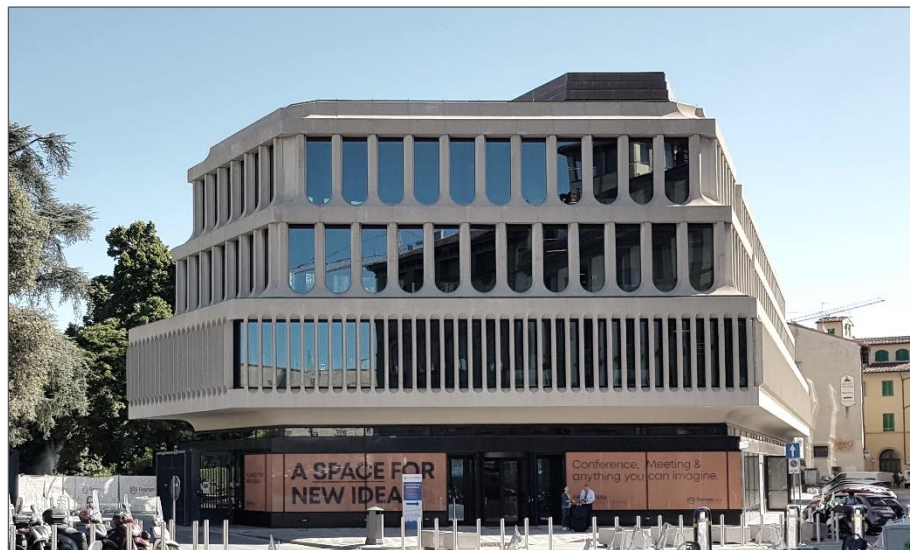
Figura 7.6. Firenze, Palazzo degli Affari. Vedute del prospetto principale dopo l'intervento di restauro conservativo (foto M. Castellini, 2022).
