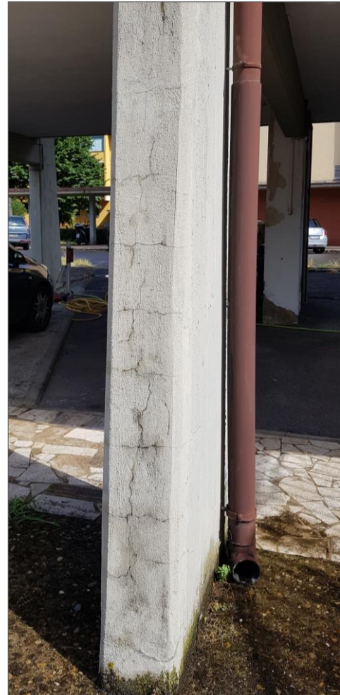
Figura 3.6. Dettaglio dei segni di deterioramento sui pilastri del terzo blocco, lato sud, maggiormente esposti alle piogge battenti.
